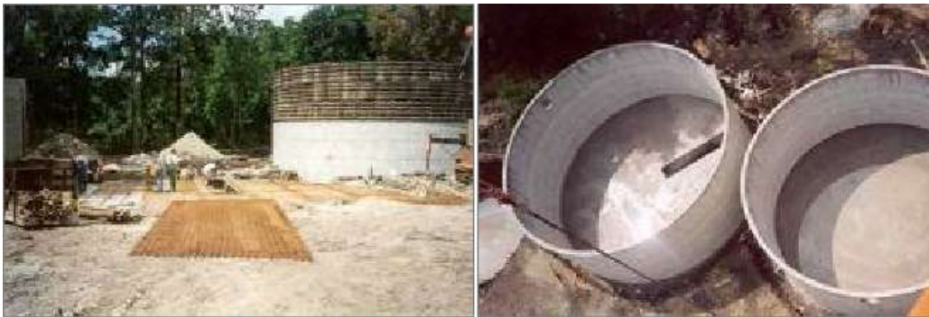
En las fotografías anteriores se puede ver el tejido de la losa de cimentación de un digester de construcción alemana.
