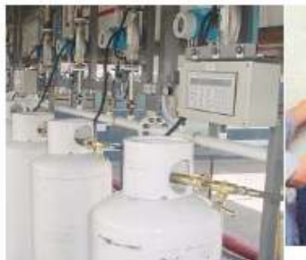
Grafico 6.8 estación para llenado de tambos de gas.
