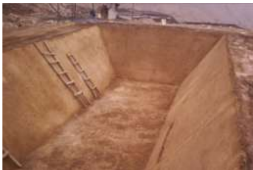
Rasante reforzada con malla y cemento para prevenir derrumbes.
