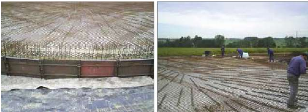
En las fotografías anteriores se puede ver el tejido de la losa de cimentación de un digester de construcción alemana.
