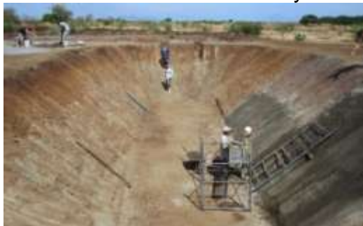
Rasante reforzada con malla y cemento para prevenir derrumbes.
