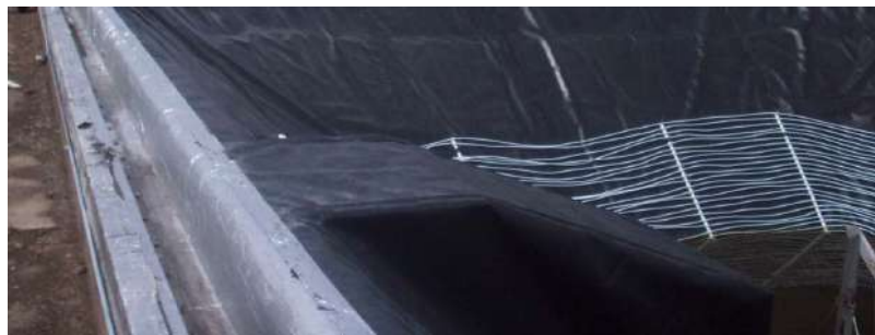
DETALLE SELLO HIDRAULICO
