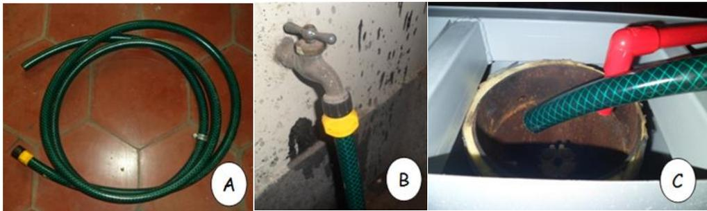
Figura 4.9 a) Manguera de alimentación de agua fría, b) Conexión de la manguera en el grifo, c) Llenar como se muestra el calentador de agua.
