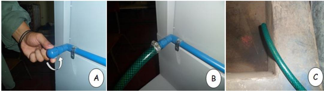
Figura 4.11 a) Girar en sentido anti horario, b) Conectar a la boquilla y apretar la abrazadera, c) Colocar la manguera al desagüe.
