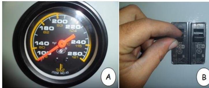
Figura 4.14 a) Termómetro calentador de agua, b) Colocar en posición OFF.
