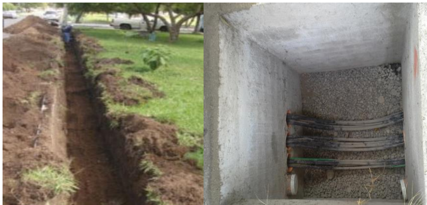
Figura 16 Zanja, canalización y pozos de registros
