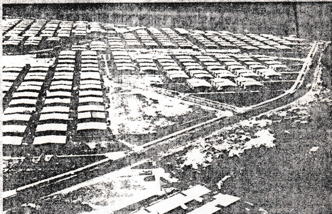
Colonia Santa Lucía ejemplo de un conjunto de viviendas unifamiliares construidas por el (IVU). Comprende 5.800 viviendas, escuela, campo de deportes y todas las demás necesidades básicas para la comunidad. Fig. 21
