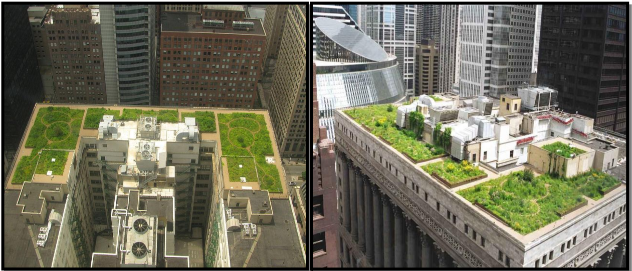
F64. Utilización de Geotextil en cubierta, Chicago's City Hall
