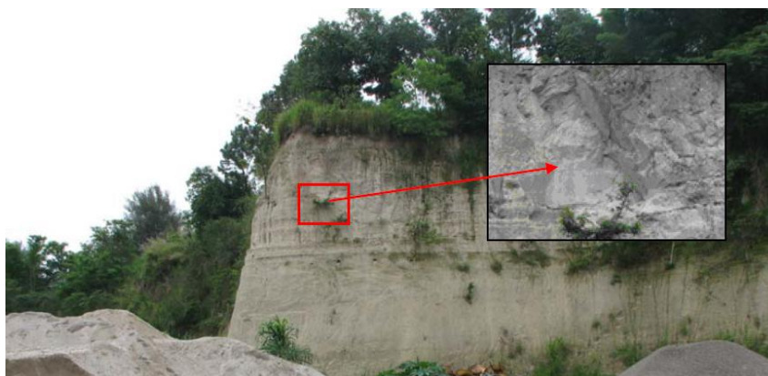
Figura No. 2.9. Mecanismo de ruptura tipo ventana en un talud ubicado frente a la colonia Altos del Boulevard, San Salvador [Julio 2009].
