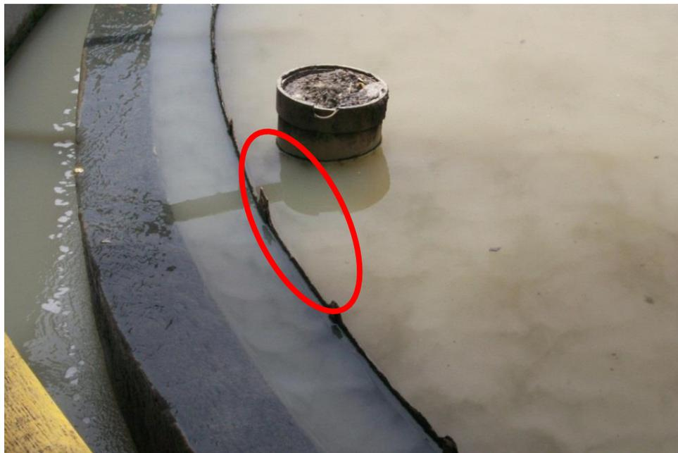
Figura N° 12: Sedimentador primario. Daño en el cincho metálico protector Permitiendo el paso de natas al sistema de filtración.
