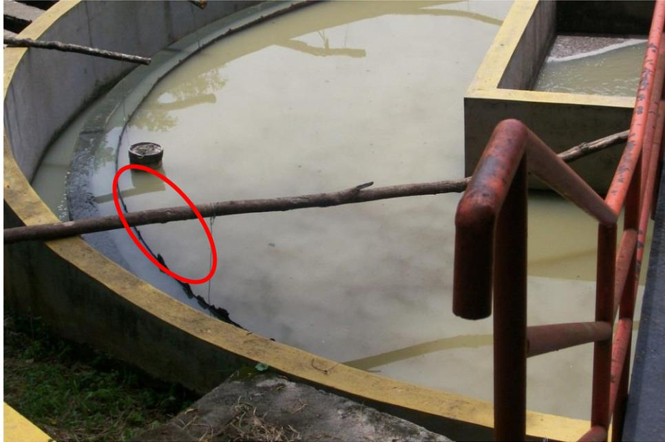
Figura N° 11: Sedimentador primario. Daño en el cincho metálico protector permitiendo el paso de natas al sistema de filtración.
