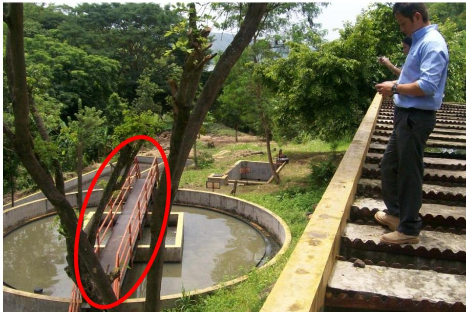
Figura N° 14: Sedimentador secundario. Pasarelas de ambos sedimentadores deteriorados por la corrosión.
