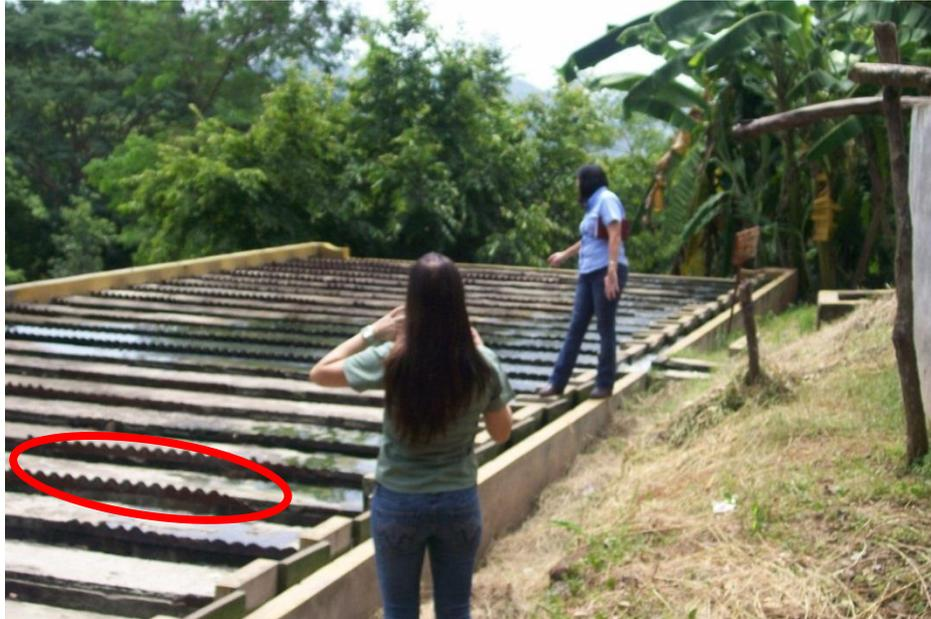
Figura N° 13: Filtro biológico. Lámina metálica dentada deteriorada por la corrosión, impidiendo de forma uniforme el vertido del flujo sobre el lecho rocoso.
