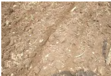
Figura N° 11 PREPARACION DEL SUELO
