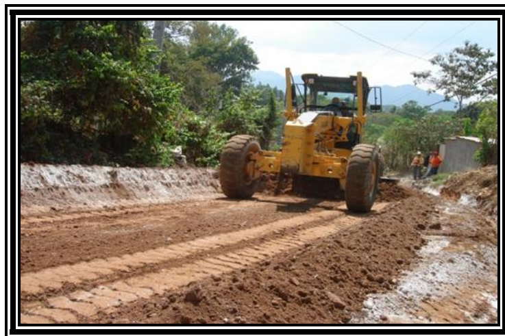
Fotografía 3.25 Conformación del Material Mezclado
