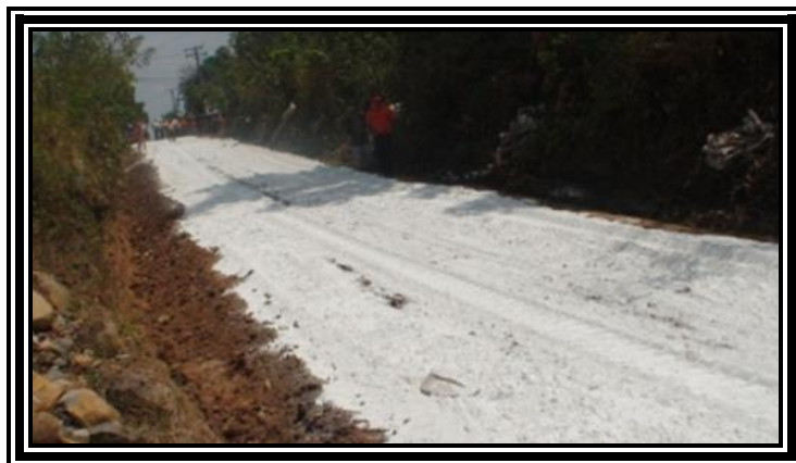
Fotografía 3.21 Distribución del Material Estabilizante (Cal)
