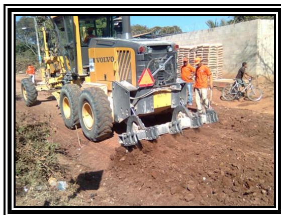
Fotografía 3.2 Escarificación del Suelo Natural
