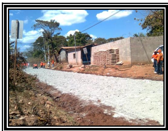
Fotografía 3.8 Distribución de las bolsas de Cemento
