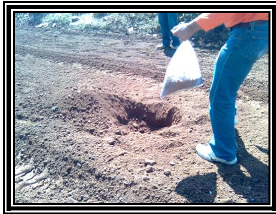
Fotografía 3.10 Extracción de material para el chequeo de humedad
