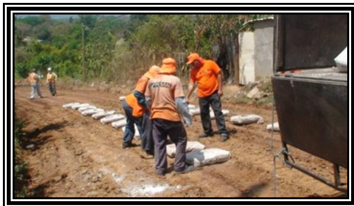
Fotografía 3.16 Distribución de las Bolsas de Cal
