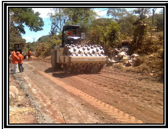
Fotografía 3.12 Compactación del Tramo de Prueba
