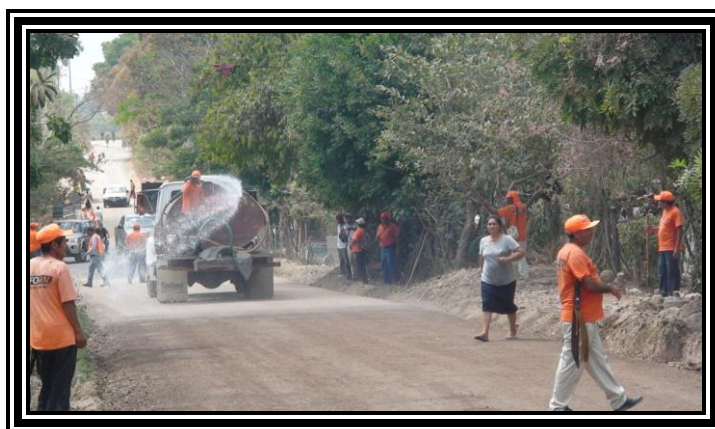
Fotografía 3.36 Humedecimiento de la Superficie de Rodadura
