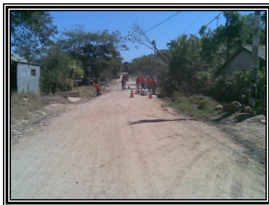
Fotografía 3.1 Estado de la Ruta CUS18E antes de la construcción de los tramos de prueba
