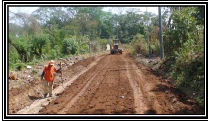
Fotografía 3.15 Escarificación del Suelo Natural
