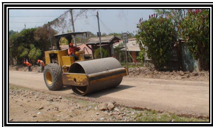
Fotografía 3.35 Compactación del Tramo de Prueba
