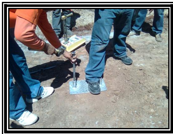
Fotografía 3.13 Chequeo de Humedad durante el proceso de Compactación por medio del Densímetro Nuclear
