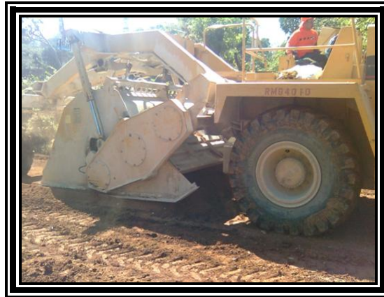
Fotografía 3.3 Pulverización y Homogeneización del Suelo Natural
