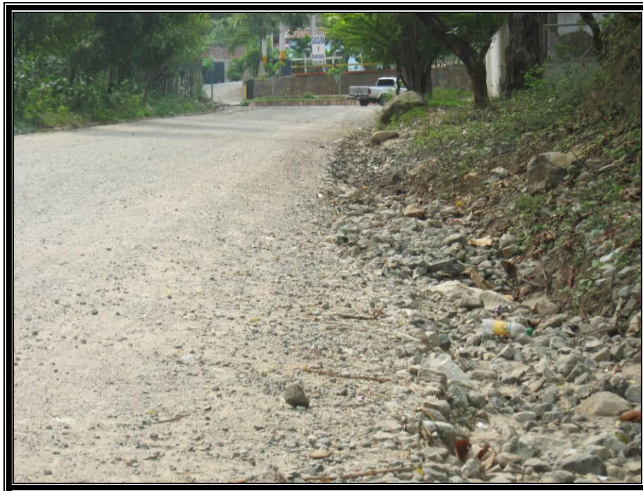
Fotografía 4.6 Drenaje Inadecuado
