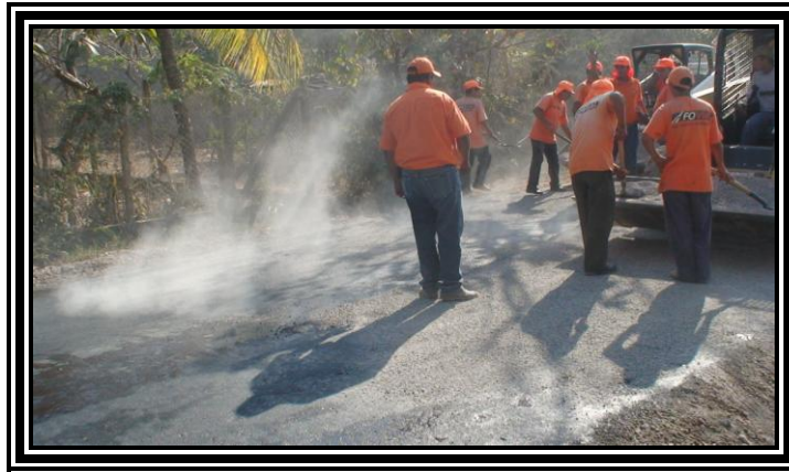
Fotografía 3.38 Colocación de Arena y Chispa para el Curado
