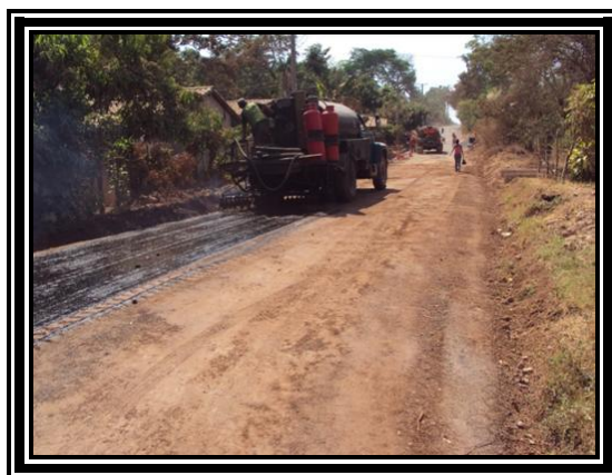
Fotografía 3.50 Riego de Emulsión para la Imprimación Asfáltica
