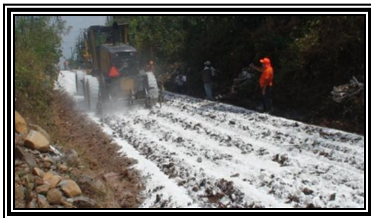
Fotografía 3.22 Mezclado del Material Estabilizante con el Suelo Natural
