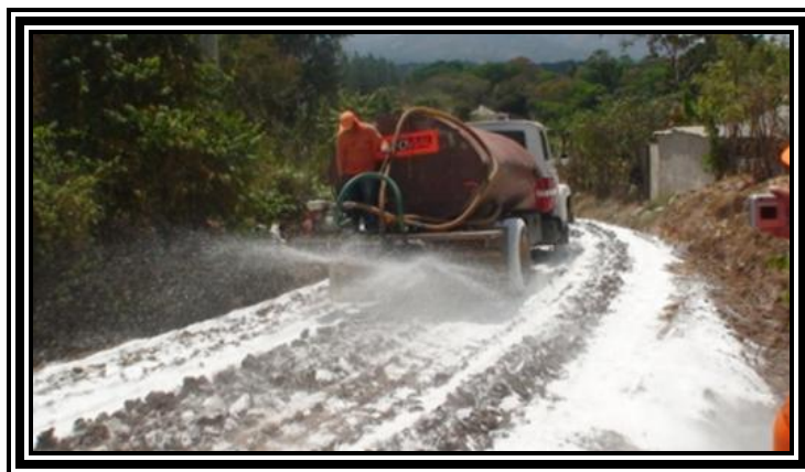
Fotografía 3.23 Humedecimiento de la Mezcla Suelo + Cal
