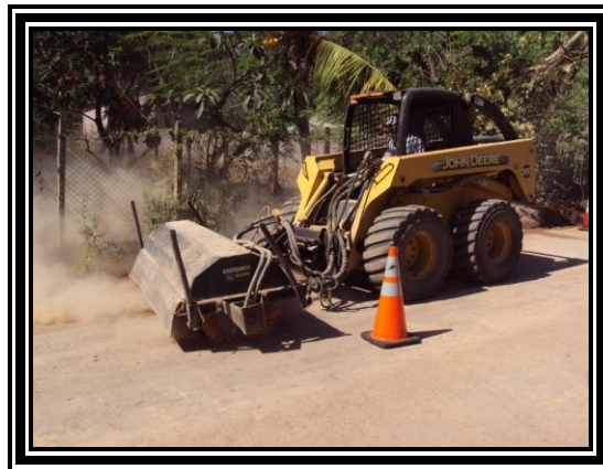
Fotografía 3.39 Eliminación de Finos presentes en la Calzada
