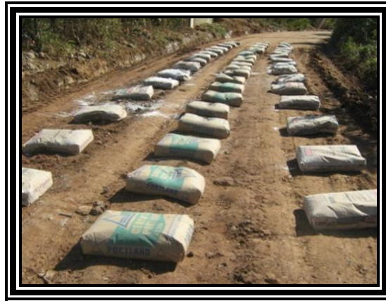
Fotografía 3.48 Distribución de las Bolsas de Cemento y Cal
