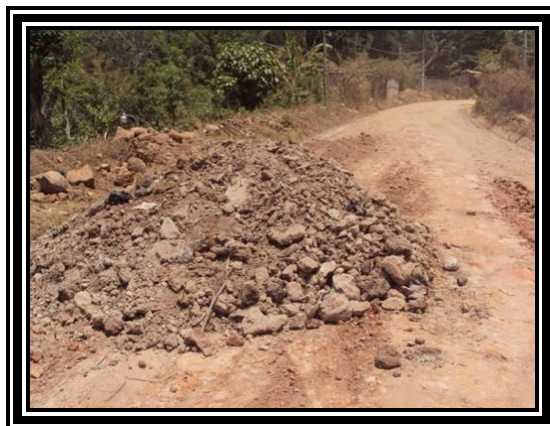
Fotografía 3.46 Material proveniente de Banco de Préstamo para Subsanan pendiente de bombeo
