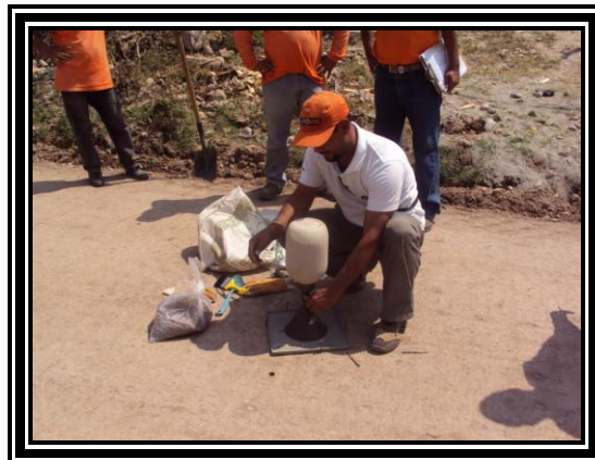
Fotografía 3.43 Toma de densidades por medio del Ensayo de Densidad de Campo
