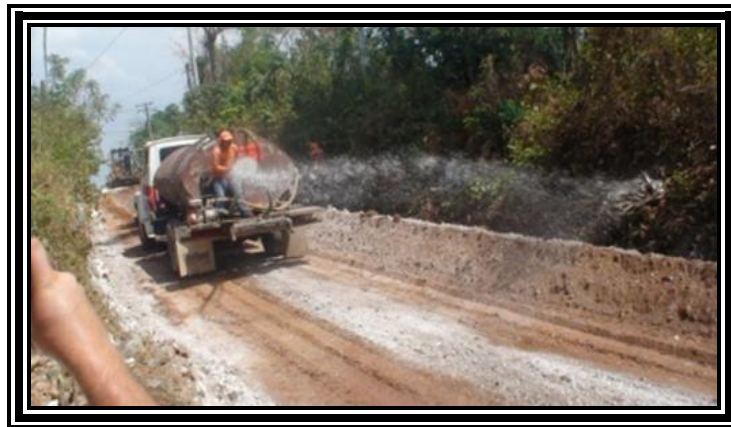
Fotografía 3.24 Humedecimiento de la Mezcla Suelo + Cal
