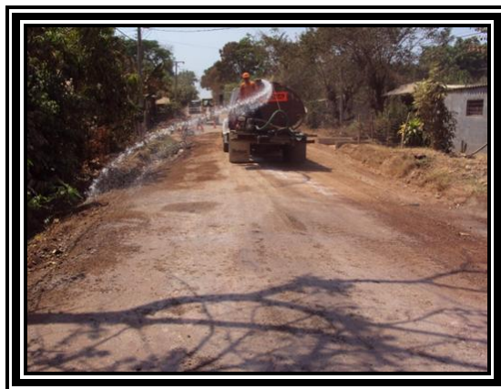
Fotografía 3.49 Humedecimiento de la Superficie de Rodadura
