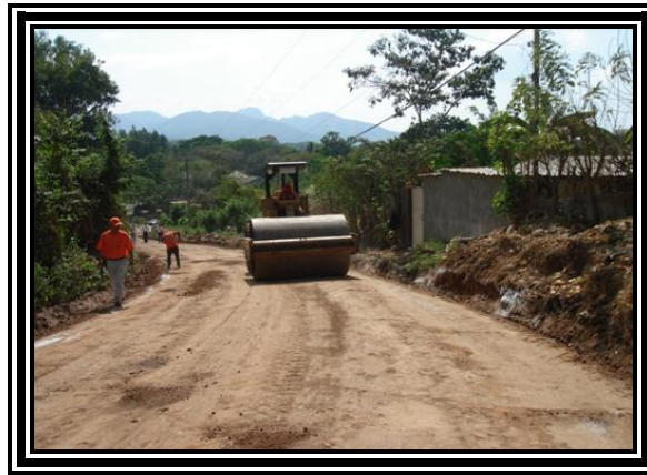
Fotografía 3.26 Compactación del Tramo de Prueba
