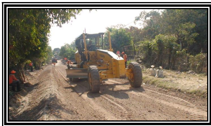
Fotografía 3.32 Formación del Caballete previo al Riego de Emulsión Asfáltica
