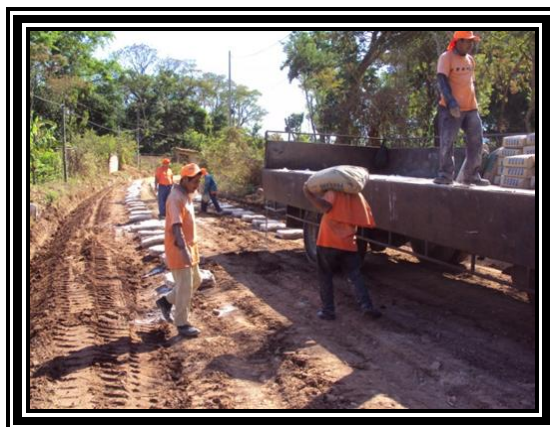
Fotografía 3.47 Distribución de las Bolsas de Cemento y Cal
