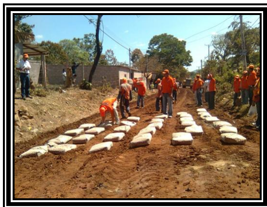
Fotografía 3.5 Distribución de las bolsas de Cemento
