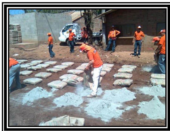
Fotografía 3.6 Distribución de las bolsas de Cemento
