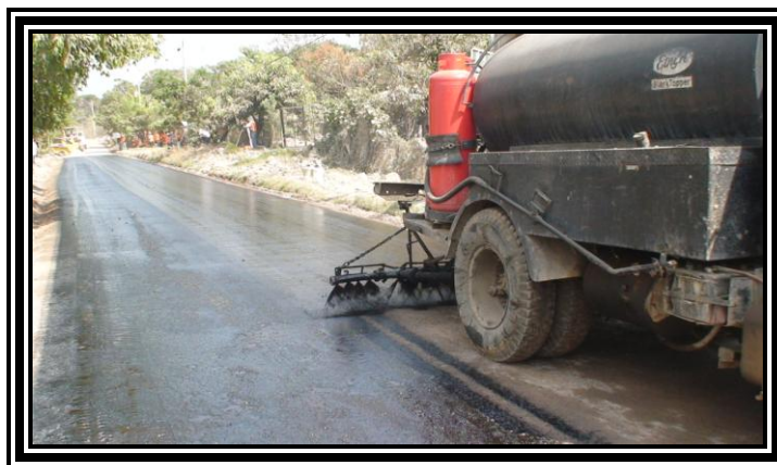
Fotografía 3.37 Riego de Emulsión para la Imprimación Asfáltica
