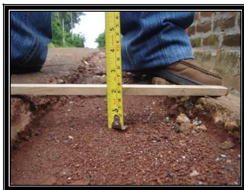
Fotografía 5.4 Empalme entre la vía y la Canaleta Construida
