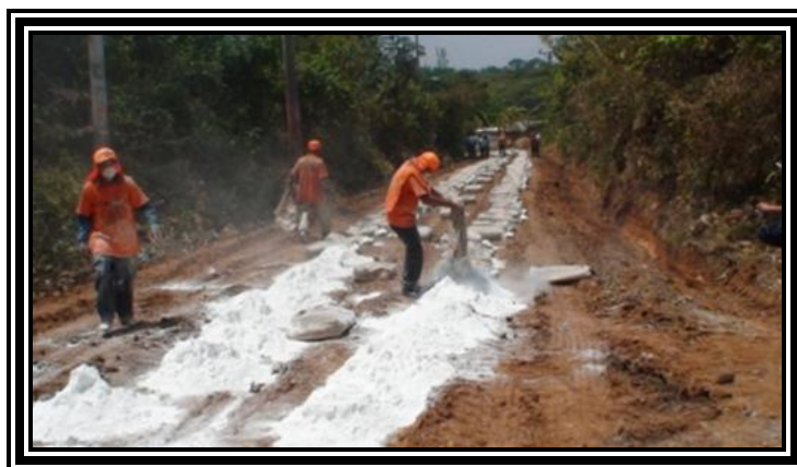
Fotografía 3.18 Distribución del Material Estabilizante (Cal)
