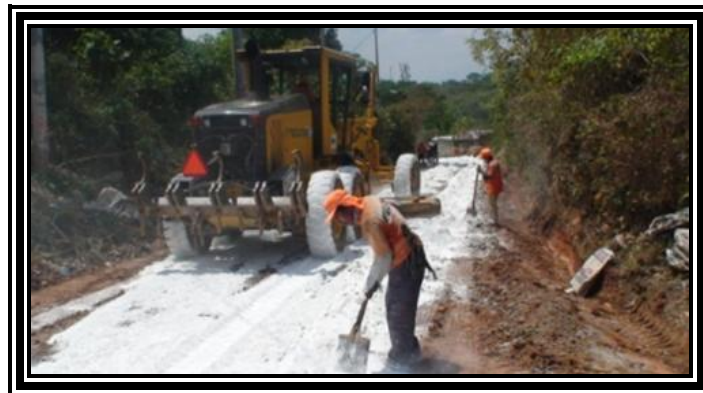
Fotografía 3.20 Distribución del Material Estabilizante (Cal)
