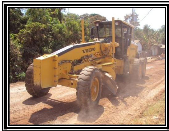
Fotografía 3.45 Escarificación del Suelo Natural
