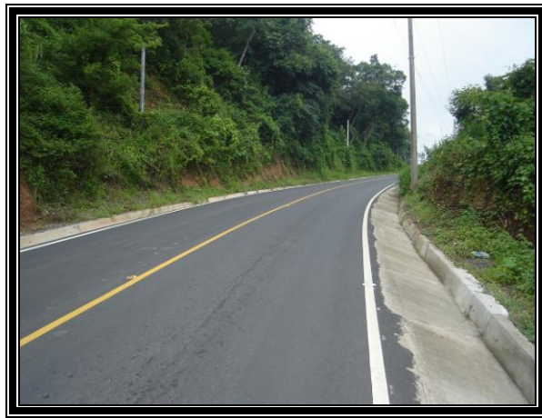
Fotografía 1.2 Tramo Pavimentado; Ruta LIB12 / Nuevo Cuscatlán - Huizúcar
