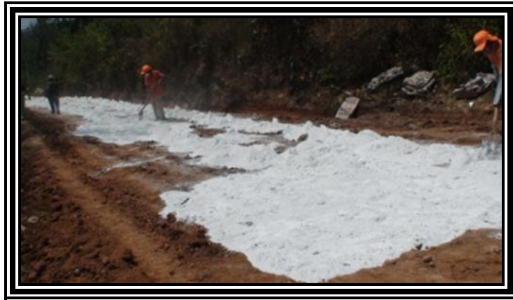
Fotografía 3.19 Distribución del Material Estabilizante (Cal)
