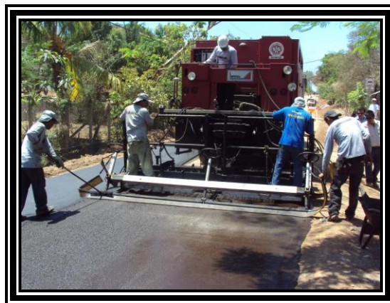
Fotografía 3.40 Colocación del Slurry Seal
