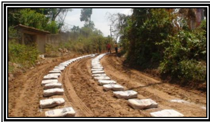
Fotografía 3.17 Distribución de las Bolsas de Cal
