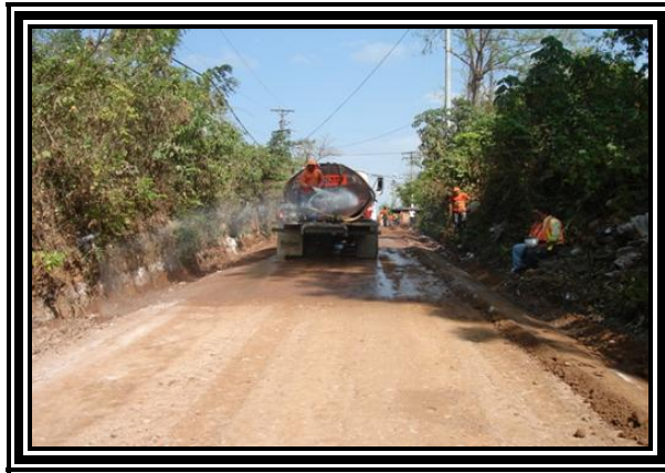
Fotografía 3.27 Humedecimiento de la Superficie de Rodadura
