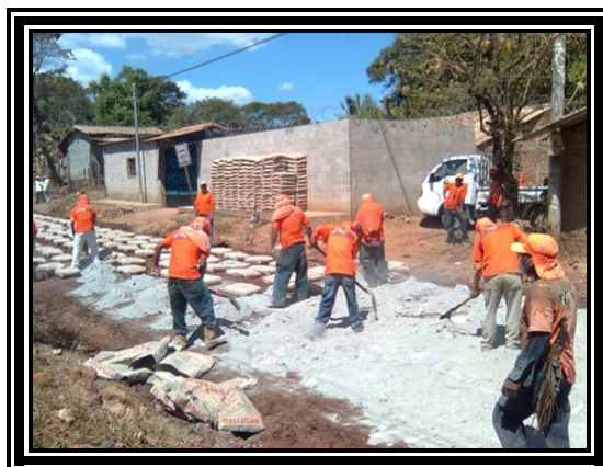
Fotografía 3.7 Distribución de las bolsas de Cemento
