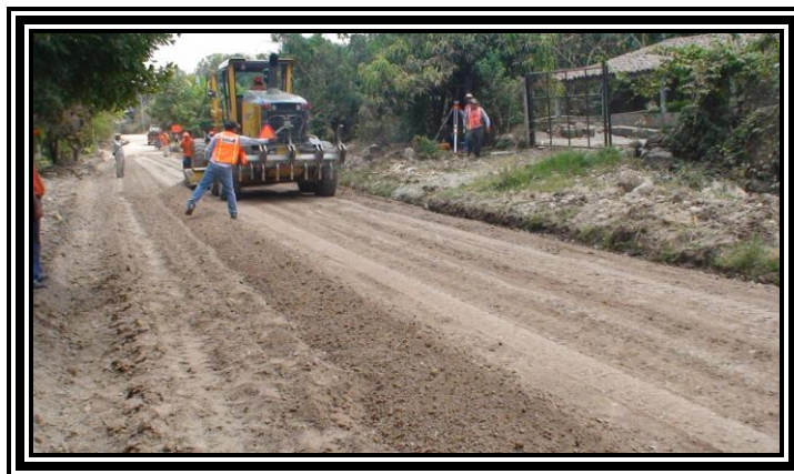
Fotografía 3.34 Conformación de la Calzada previa a Compactación
