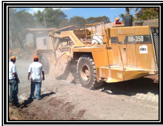
Fotografía 3.9 Mezclado del Suelo Existente con el Material Estabilizante (Cemento)
