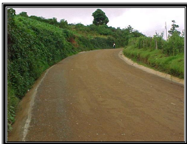
Fotografía 1.4 Pendiente Longitudinal de Aprox. 12 % en buen estado, después de dos inviernos; Río Chiquito – Las Pilas, Chalatenango
