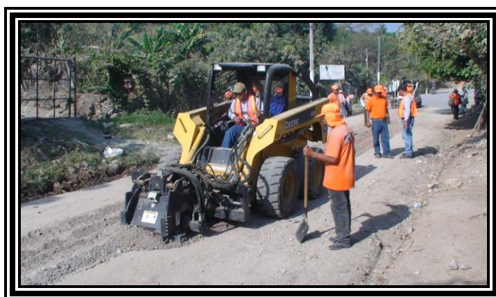
Fotografía 3.31 Escarificación del Suelo Natural
