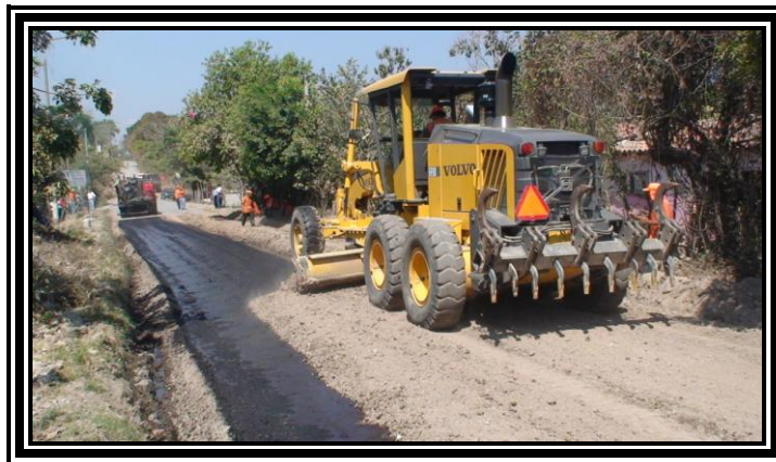
Fotografía 3.33 Riego de Emulsión Asfáltica por capas
