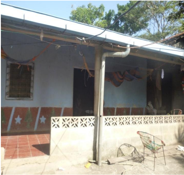
Fotografía 1.12. Vivienda en Cantón San Matías, en la cual está construida de bloque, duralita y ladrillo el piso. Las condiciones son un poco más cómodas que la mayoría de familias del lugar.
