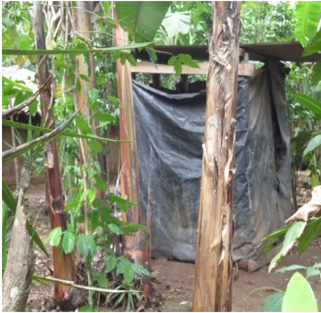
Fotografía 1.9, El servicio sanitario de una vivienda en Cantón El Porvenir en Ciudad Barrios
