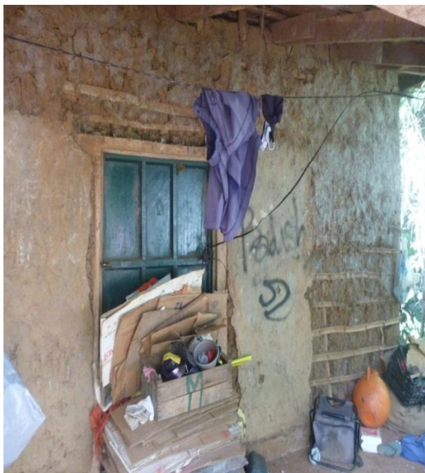
Fotografía 1. 5 Parte externa de una vivienda en el Cantón San Cristóbal de Ciudad Barrios, en donde se observa que está construido de bahareque lo cual denota la miseria en que viven las
