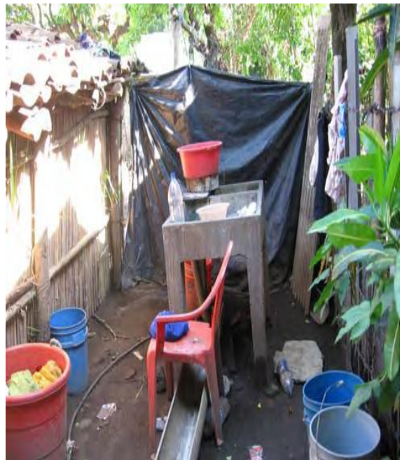
Fotografía 1.15 Lavadero de una vivienda en Cantón Guanaste de Ciudad Barrios, ambas fotografías muestran condiciones paupérrimas en las que viven las familias de estos cantones, no son viviendas dignas para ser habitadas.
