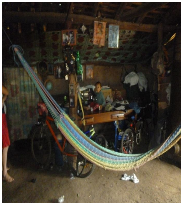
Fotografía 1. 6 Parte interna de una vivienda en el Cantón Belén, En donde se observa el piso de tierra y pared de bahareque...
