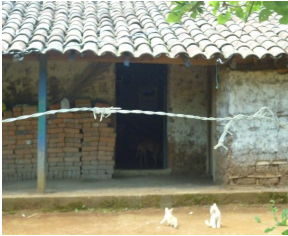
Fotografía 1.1 Parte externa de una vivienda en el Cantón Belén de Ciudad Barrios, construida a base de bahareque, teja y tierra.
