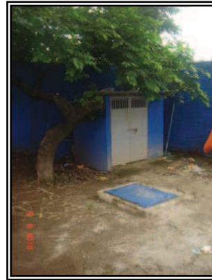
Sistema de Cisterna
