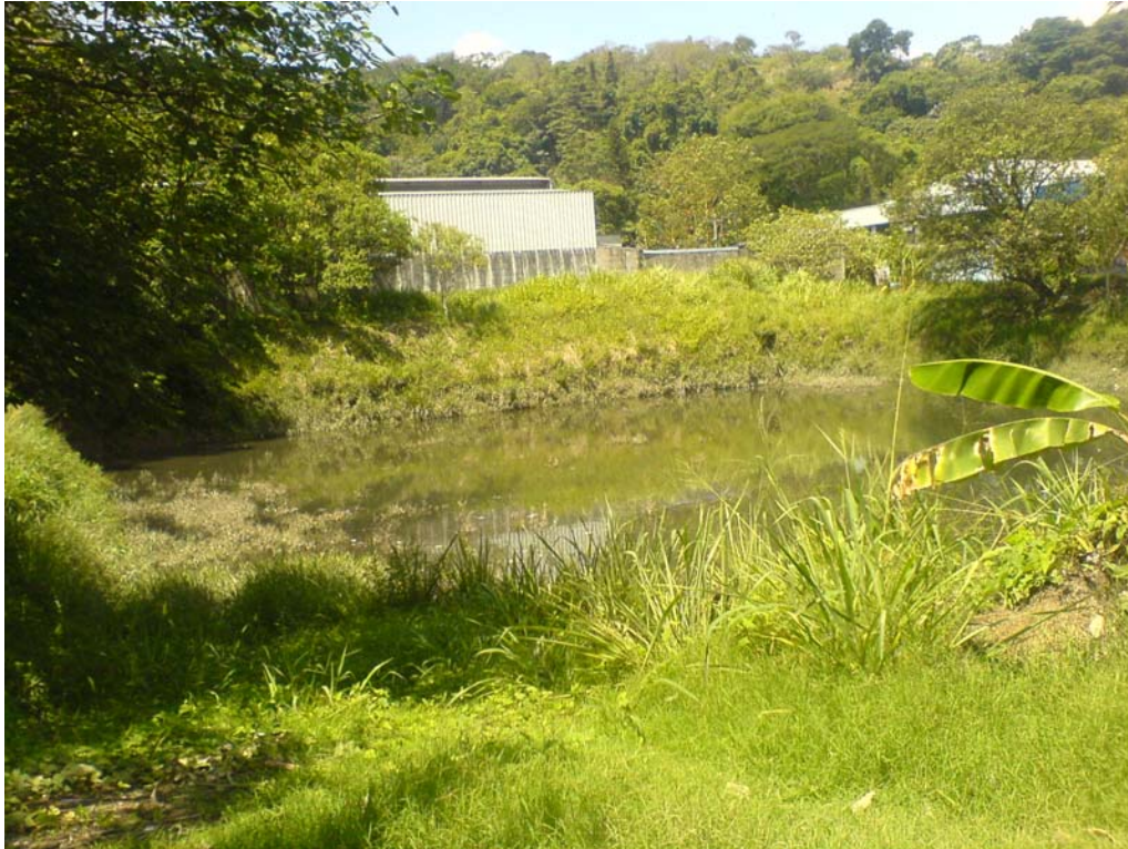
Figura 4.16 Foto de laguna de almacenamiento de aguas lluvias en Antiguo Cuscatlán
