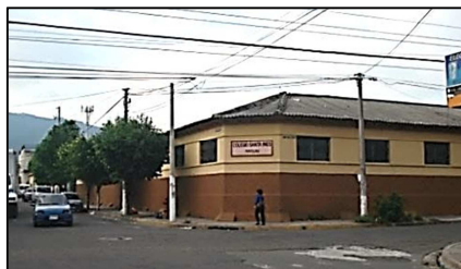
Fotografía 140: Vista volumétrica de una esquina del colegio.
