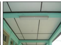
Fotografía 149: Detalle de cielo falso.
