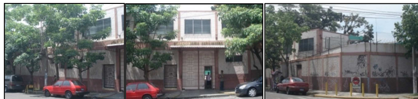
Fotografía No.159, 160 y 161: Elevación Oriente.
