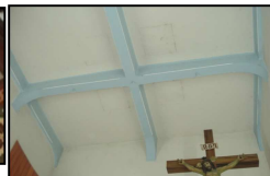
Fotografía No.183: Detalle de entepiso y vigas en la capilla.
