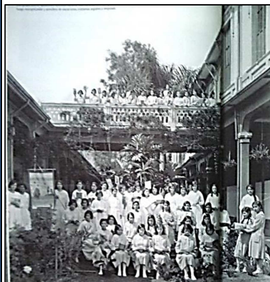
Fotografía 137: Detalle de barandal. (Fotografía antigua).
