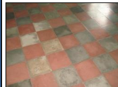
Fotografía 151: Detalle de piso en Interior.
