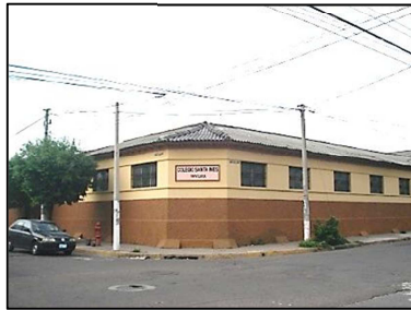
Fotografía No. 125: Detalle de esquina ochave en la fachada principal, ubicada en la intersección de la 3ª Av. Sur y 6ª Calle Oriente.
