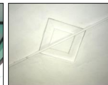
Fotografía 150: Detalle de cielo falso.
