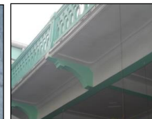
Fotografía 153: Detalle de barandal y ménsulas.
