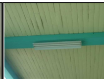
Fotografía No.184: Detalle de duela en el cielo falso y luminaria.
