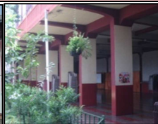
Fotografía No.172 y 173: Detalle de ventanas y columnas en el exterior.
