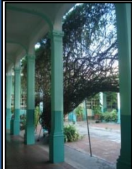
Fotografía No.142: Columna de concreto armado.
