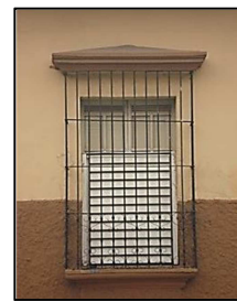
Fotografía No. 129: Detalle de ventana en la Elevación Oriente.
