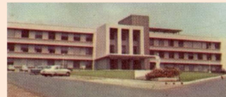
Fotografía No 8: Antiguo Edificio del Colegio Externado de San José.
