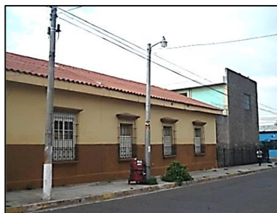
Fotografía 141: Vista lateral del colegio.
