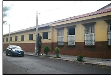
Fotografía No. 124: Elevación sobre 9ª Calle Oriente.
