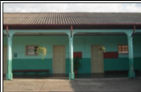
Fotografía No.143: Techo de fibrocemento.
