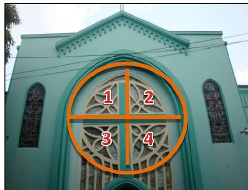
**Fotografía No.406:** Detalle de rosetón de tracería, formado por cuatro lóbulos en la Elevación Norte de la Capilla del Instituto Bethania.
