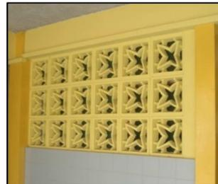
Fotografía No.327: Detalle de celosía de barro en paredes.
