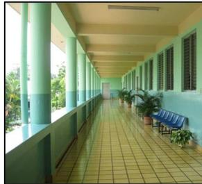
**Fotografía No.683:** Detalle de piso, vigas, entrepiso y barandal de concreto en 2do. Nivel.
