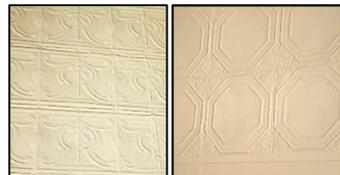
Fotografía No 297, 298 y 299: Detalle de Lámina Troquelada.
