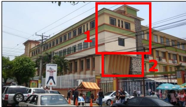
Fotografía No.637: Vista volumétrica del Edificio. Detalle de voladizos (1) y planos seriados (2)
