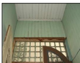
Fotografía No.400: Detalle de cielo falso tipo duela.
