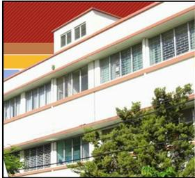
**Fotografía No.680:** Ventanas de la elevación oriente: celosía de vidrio con marco metálico.
