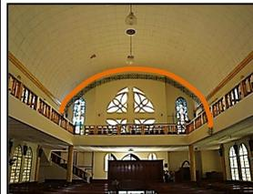
Fotografía No.412: Detalle de bóveda de cañón corrida en el área de bancas.
