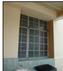
Fotografía No.628 y 629: Ventanería abatible y Remate de la elevación sur.
