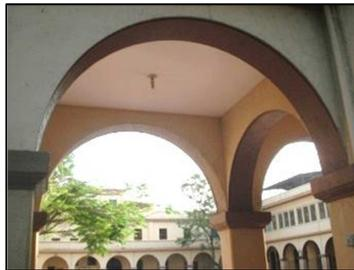
**Fotografía No.492:** Detalle de arco de medio punto en pasillos.
