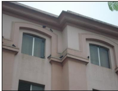
**Fotografía No.226:** Detalle de cornisa como remate en la elevación, y arcos elípticos sobre las ventanas.
