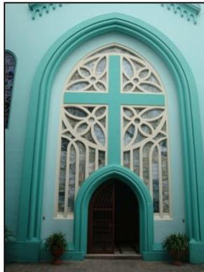
**Fotografía No.410:** Detalle de acceso, rosetón, arco ojival con vitrales y arquivoltas.
