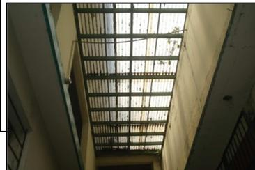
Fotografía No.355: Detalle de techo con lámina traslucida.
