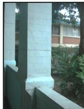
Fotografía No.399: Revestimiento de lámina troquelada en columnas.
