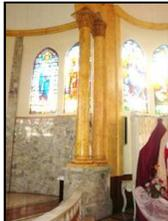
Fotografía No.422: Pedestal de mármol y capitel de madera en columnas.
