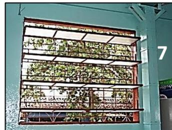
**Fotografía No.1045:** Ventanería basculante de vidrio en interiores.
