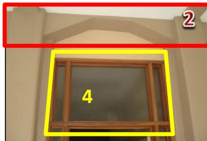
Fotografía No.1074: Viga con ochave en los extremos.
