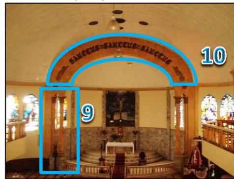
Fotografía No.1031: Detalle de altar, bóveda de cañón y arco rebajado sostenido por columnas.
