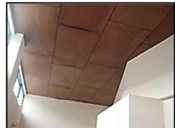
Fotografía 804: Cielo falso machihembrado.
