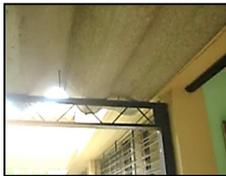
Fotografía 798: Detalle de techo (lamina de fibrocemento).
