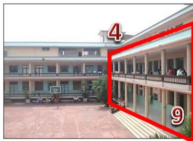
Fotografía No.1102: Columnas cilíndricas y altura del entrepiso.
