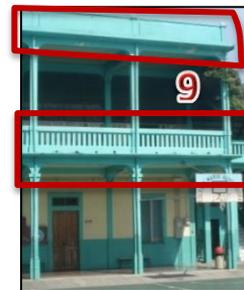
Fotografía No.939: Detalle de parapeto y barandal de concreto.
