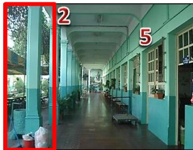
Fotografía No.924: Detalle de pasillos, de columnas con pedestal cuadrado y ochaves en las esquinas.
