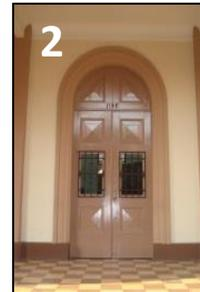
Fotografía No.1051: Detalle de puerta de metal con arco de medio punto.
