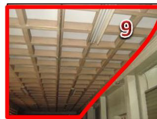
**Fotografía No.931:** Detalle de cielo falso artesonado.
