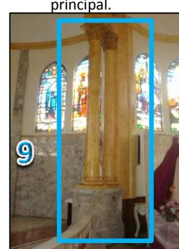
Fotografía No.1032: Detalle de doble columna de orden corintio.
