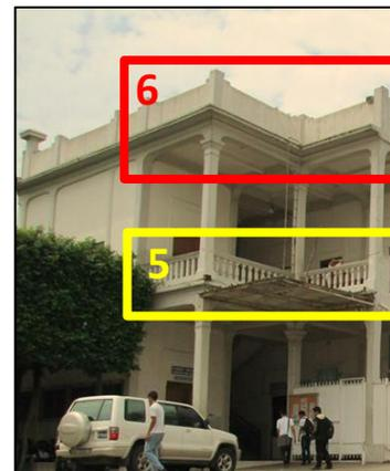
Fotografía No.944: Detalle de arco deprimido en la entrante del segundo nivel y balaustrada en el barandal de la elevación norte.
