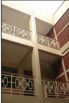
Fotografía No.850: Detalle de barandal, viga-columna y celosía de barro.
