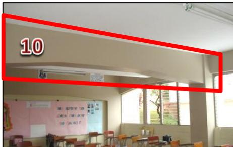
Fotografía No.1057: Detalle de viga con ochave en las esquinas en salón de clases.
