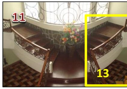
Fotografía No.1064: Detalle de escaleras tipo imperial adosada a pared circular.
