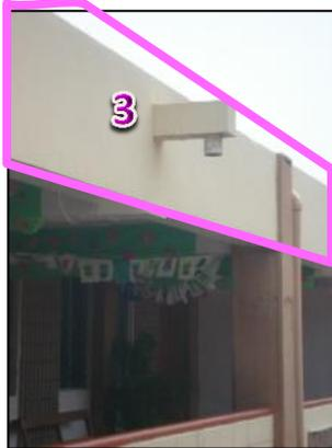
Fotografía No.1036: Parapeto al interior del edificio y detalle de bajada de aguas lluvias.
