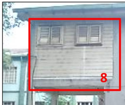
Fotografía No.1021: Paredes de deployer y madera en lienzo en la saliente de la pared norte.
