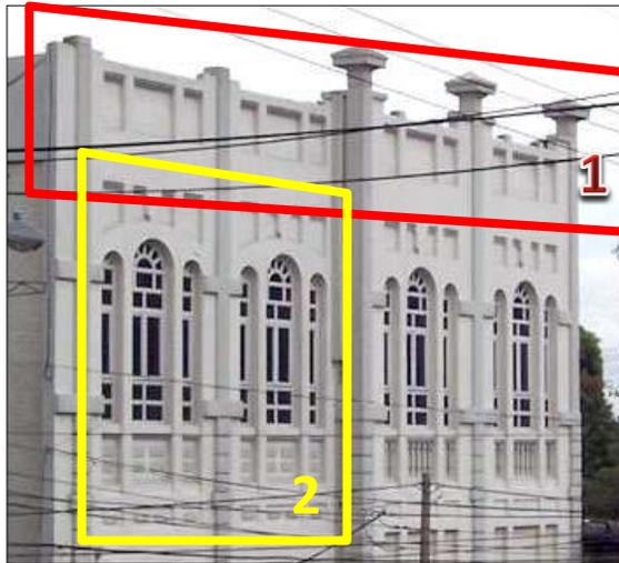
Fotografía No.940: Detalle de ventanería abatible de vidrio con arco de medio punto, con vidrio fijo arriba y a los lados.
