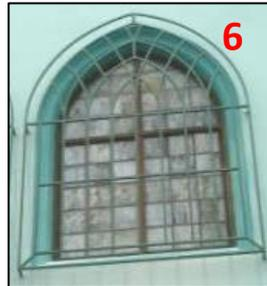
Fotografías No.1026 y 1027: Detalle de ventanería de vano con arco ojival y vitrales.
