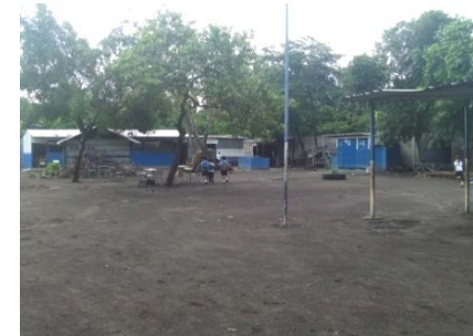
Fotografía 24: Instalaciones del Centro Escolar Caserío Nuevo Consumidero.
