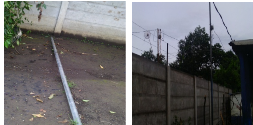
Fotografía 64: Instalaciones del Centro Escolar Caserío Nuevo Consumidero.
