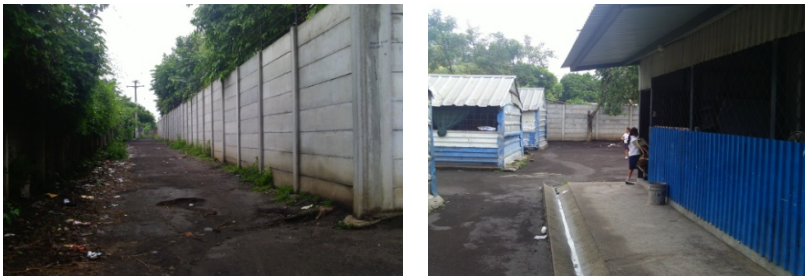
Fotografía 63: Instalaciones del Centro Escolar Caserío Nuevo Consumidero.
