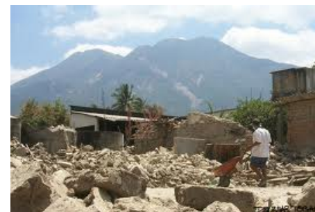
Fotografía 22: Destrucción de viviendas en Caserío El Consumidero, durante el terremoto del 13 de Enero de 2001.
