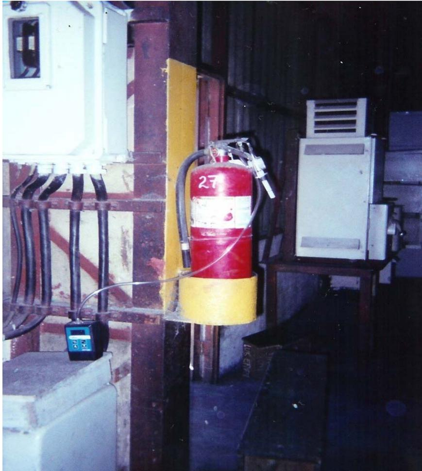
**Figura N°8. Fotografía de una Bomba de Flujo Constante colocada en un punto de muestreo dentro de las instalaciones de un ingenio.**
