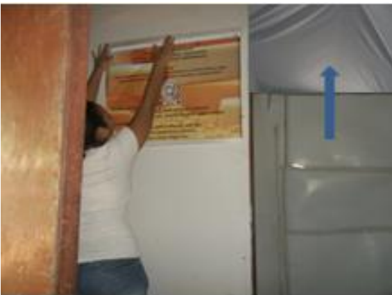
Imagen 4. Colocación de cielo falso de tela color blanco.
