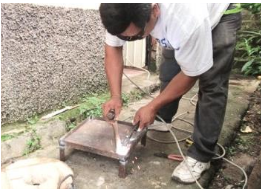
Figura 61 Soldadura eléctrica de piezas del pedestal
