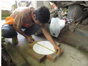
Figura 35 Medición y dibujo con plantilla sobre ladrillos refractarios
