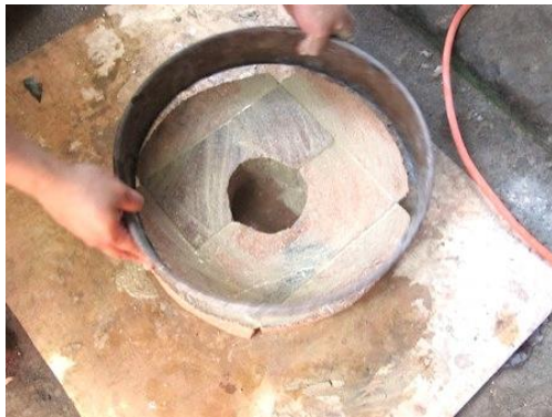
Figura 57 Acomodamiento de la tapadera de ladrillos dentro del aro metálico
