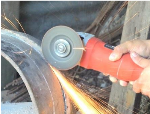
Figura 55 Corte del anillo metálico para revestimiento de la tapadera
