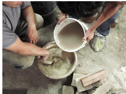
Figura 44 Preparación de pasta refractaria para pega de ladrillos.
