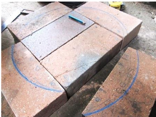
Figura 53 Dibujo del contorno de la tapadera
