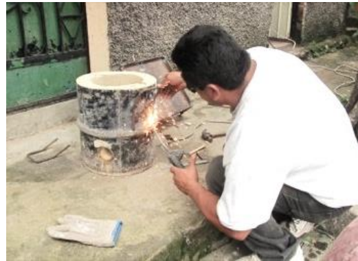
Figura 62 Soldadura eléctrica de las agarraderas del horno
