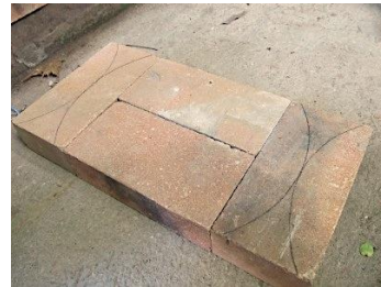
Figura 36 Dibujo de contornos de la base de ladrillos
