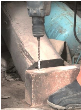
Figura 51 Perforación de los ladrillos con taladro.
