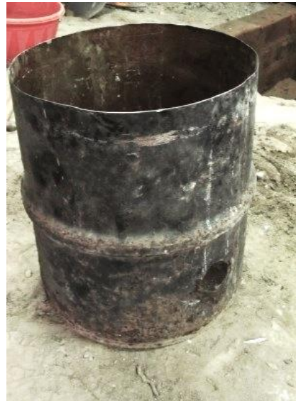
Figura 42 Revestimiento metálico con agujero de conducto de entrada del quemador.
