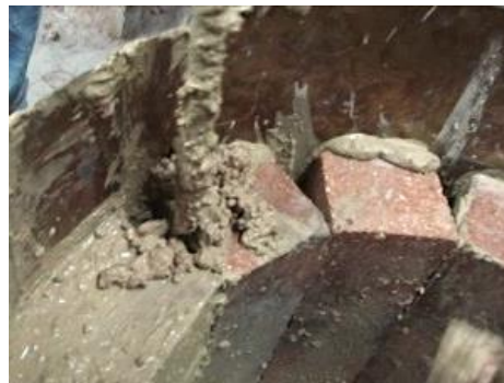
Figura 48 Llenado de las hendiduras entre los ladrillos de las paredes.
