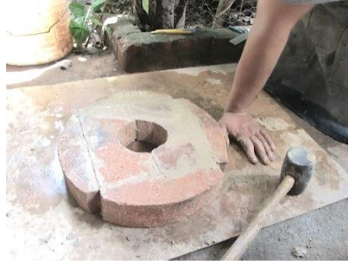
Figura 56 Unión de los ladrillos por sus ensambles aplicando pasta refractaria
