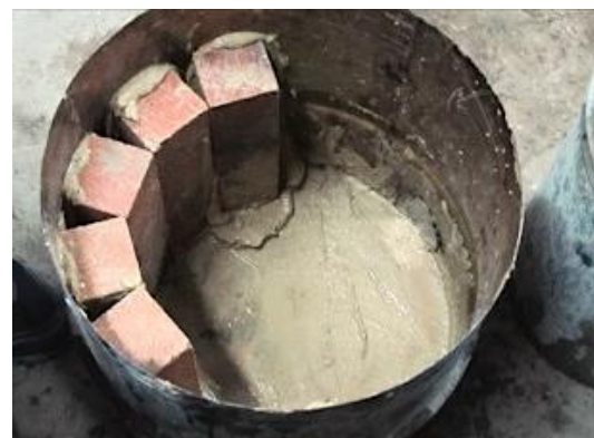
Figura 46 Pega de ladrillos en las paredes del horno.
