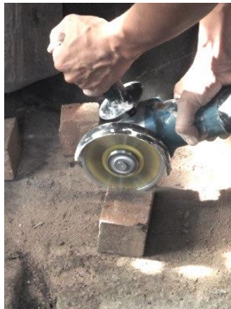
Figura 43 Corte de ladrillos para las paredes del horno.
