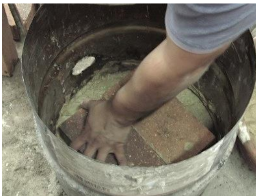
Figura 45 Pega de ladrillos con en el interior del revestimiento.
