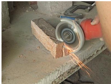
Figura 37 Corte de ladrillo con esmeril angular y disco diamantado
