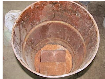
Figura 38 Comprobación de ladrillos al interior del revestimiento
