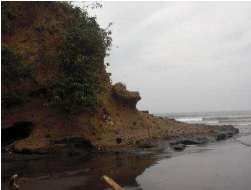
Figura 15. Fotografía, muestra el pie del acantilado localizado a 1400 m de la Bocana El Limón, rumbo sureste sobre el cordón litoral de Acajutla, el cual por efectos de las olas y de agentes biológicos ha ido degradando su base y cuerpo. Fotografía tomada el 24 de mayo 2009.
