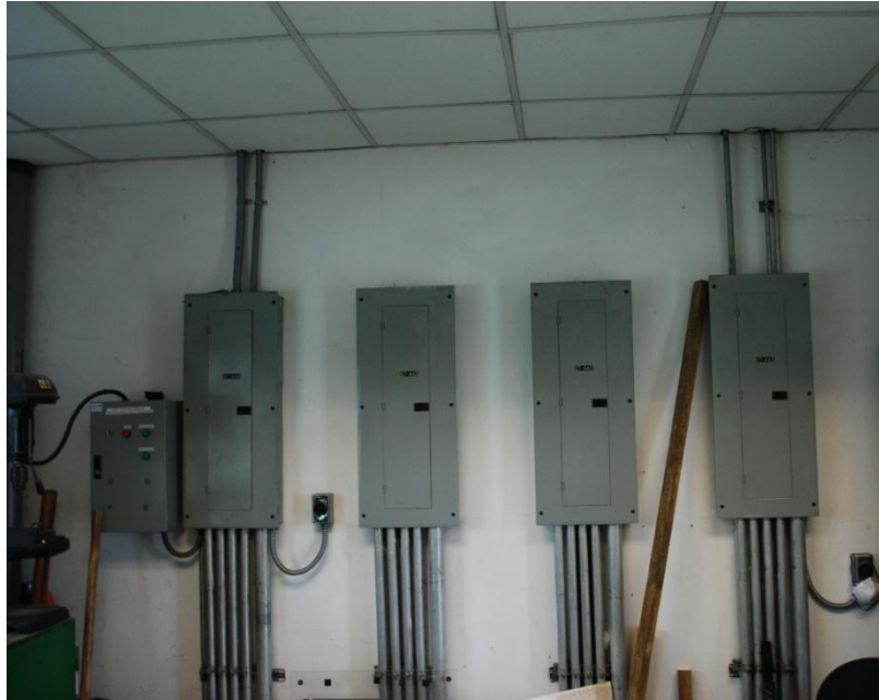
FIGURA 11 UBICACION DE SUBTABLEROS DE AIRES ACONDICIONADOS
