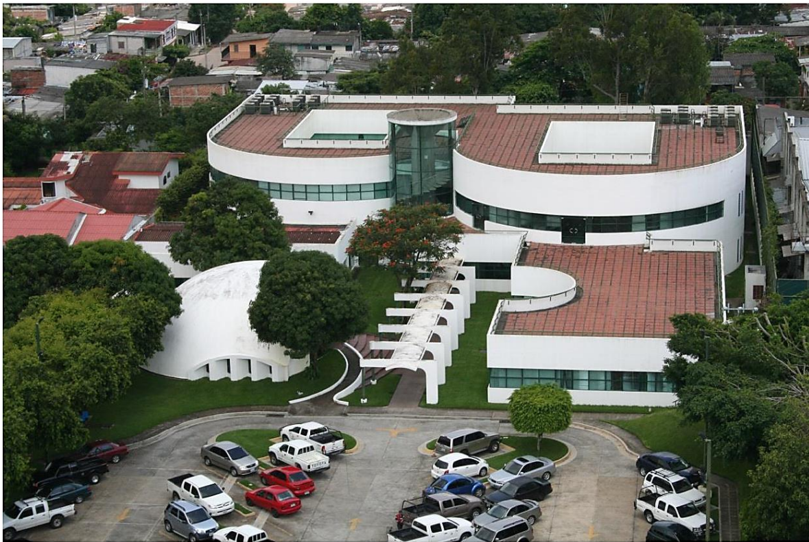
FIGURA 24. INSTALACIONES DEL EDIFICIO ADMINISTRATIVO LaGeo SANTA TECLA
