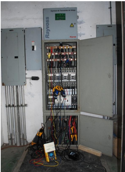
FIGURA 8 TABLERO GENERAL DE LUCES Y TOMAS.
