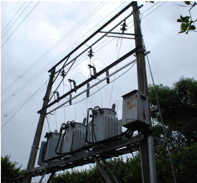
FIGURA 7 SUBESTACION DE 300 KVA PARA AIRES ACONDICIONADOS DE LAGEO
