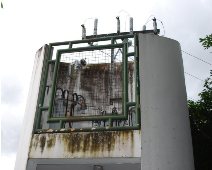
FIGURA 6 SUBESTACION DE 225 KVA DE LUCES Y TOMAS GENERAL DE LAGEO
