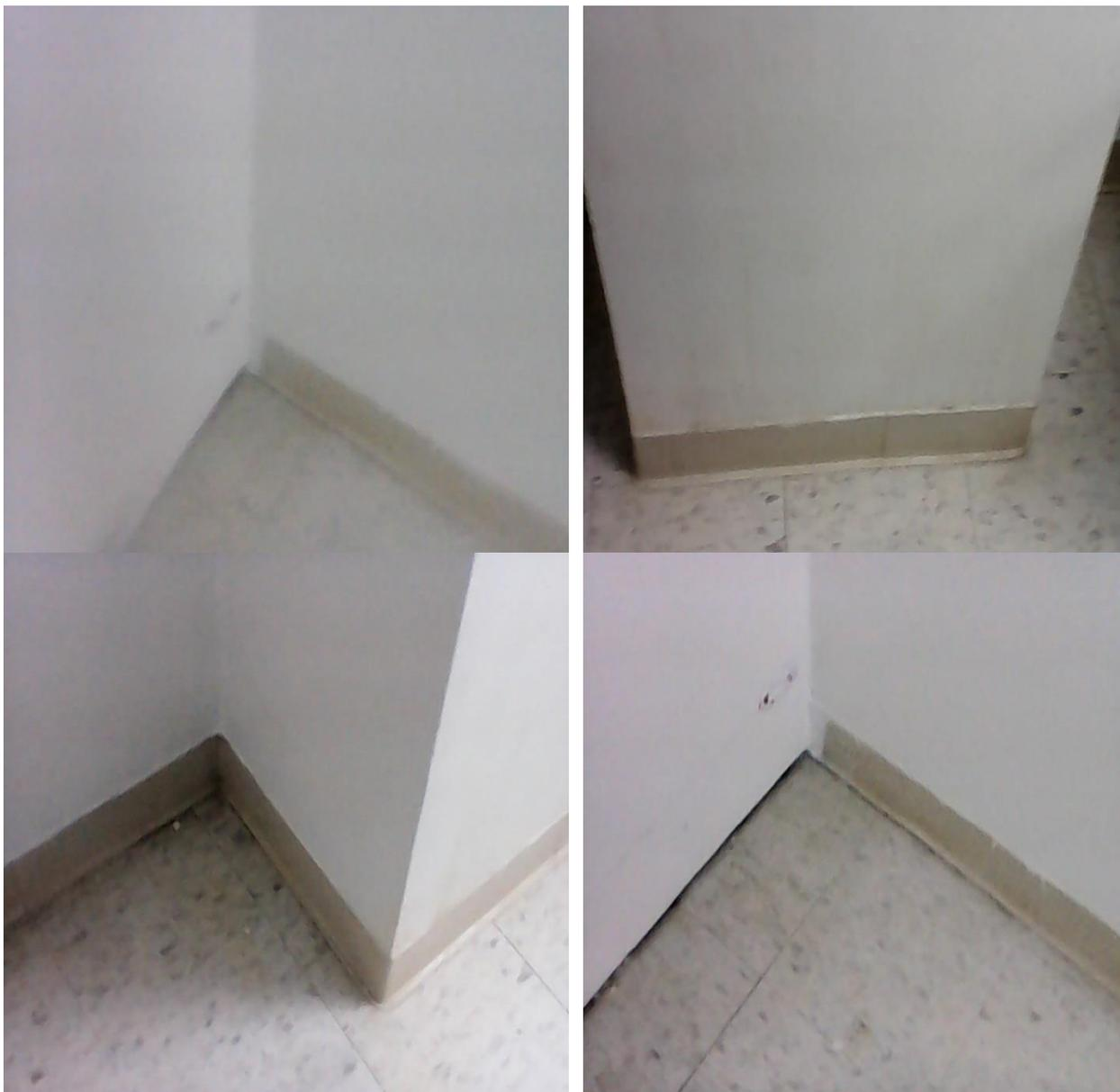
Figura N° 8. Unión de las paredes del área blanca con el piso.
