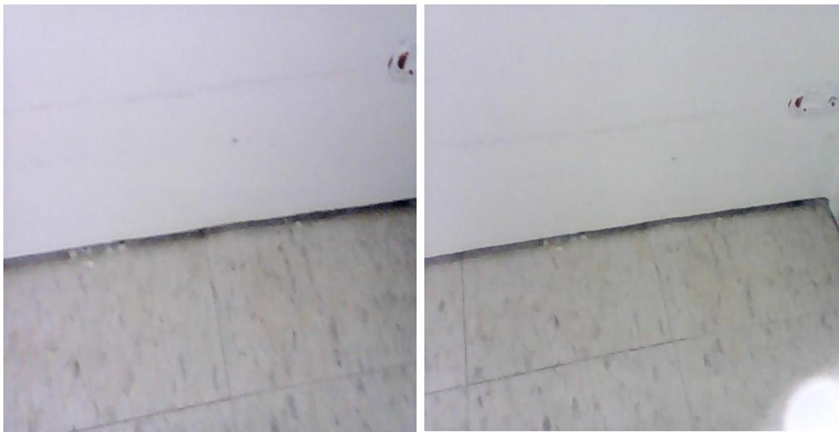
Figura N° 9. Unión de pared con piso sin acabado sanitario.
