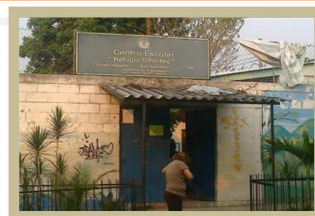
Fotografía No. 6 Centro Escolar Refugio Sifontes
