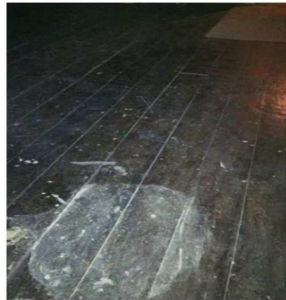
Piso ubicado detrás de bambalinas. En el fondo existe una fractura ya que está cubierta por lámina de madera contrachapada (plywood).
