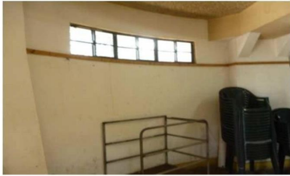
Vista de las paredes de concreto. Al interior se observan bien conservadas en pintura y repello.
