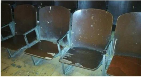
Vista de las butacas donde se observa descascamiento y suciedad de pintura.
