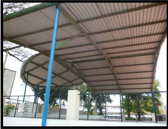
IMG.132 Vista de las cubiertas al exterior del teatro
