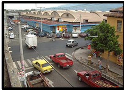
IMG.58 Vista aérea del mercado desde la 21ª Calle Pte.
