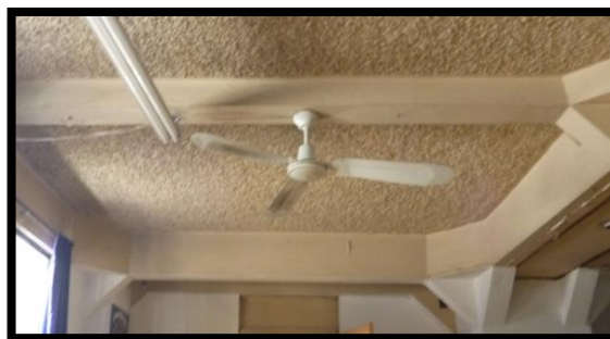
IMG.131 Vista de las vigas y la losa que encubre el teatro
