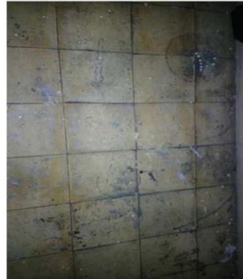
Piso ubicado en los pasillos laterales del Auditorio.
