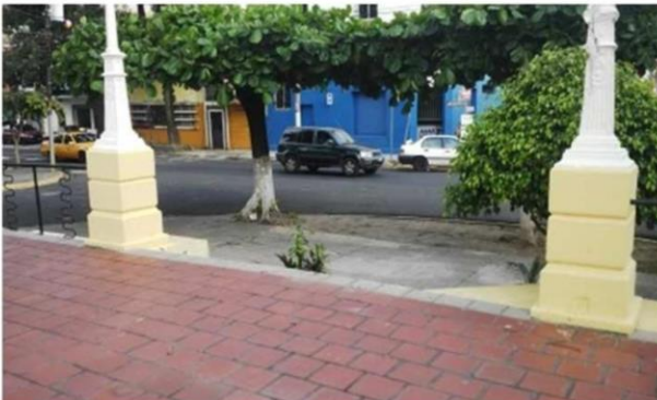
Vista del embaldosado.
