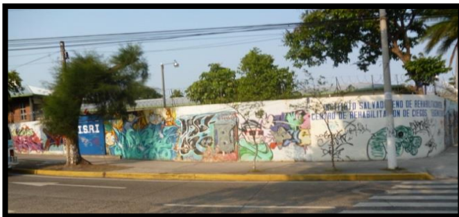
IMG.16 Grafitis en Centro de Rehabilitación para Ciegos Eugenia de Dueñas
