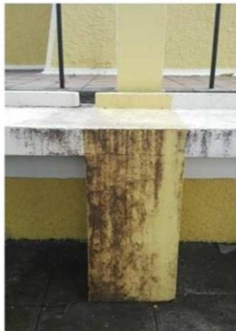
Vista de las paredes al exterior afectadas por eflorescencias debido a la humedad.
