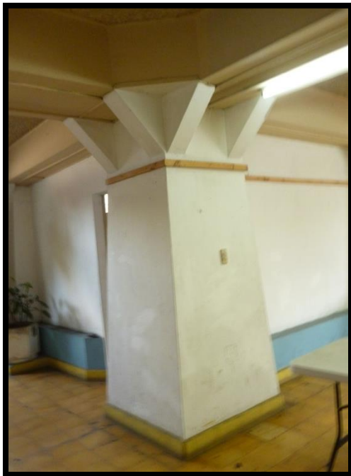
IMG.129 Vista de las columnas del teatro
