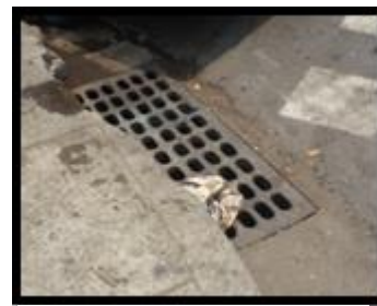
IMG.27 Tragante de Aguas Lluvias sobre la 2da Av. Nte.
