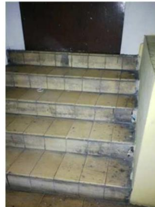
Vista del piso en las gradas que conducen hacia la parte posterior del escenario.
