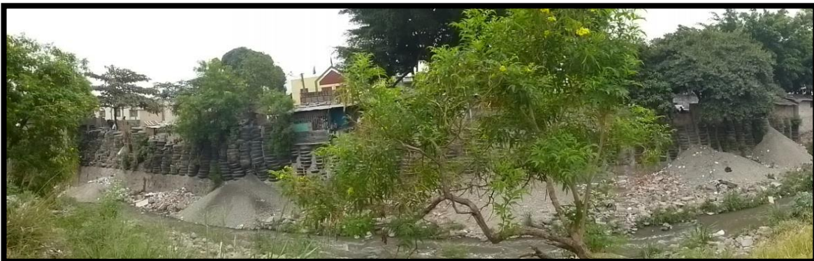
IMG.13 Vista general del Arenal Tutunichapa
