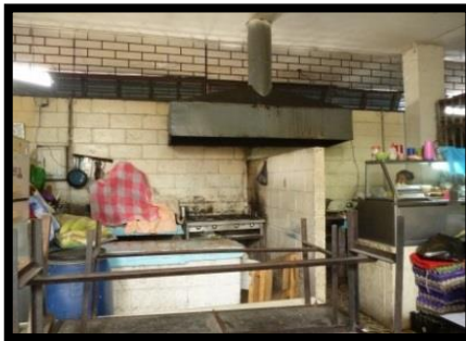
IMG.80 Cocinas con humedad moderada
