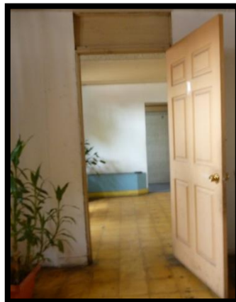
IMG. 136 Las puertas son de madera.
