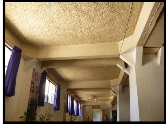
IMG.133 Vista de las cubiertas al interior del teatro
