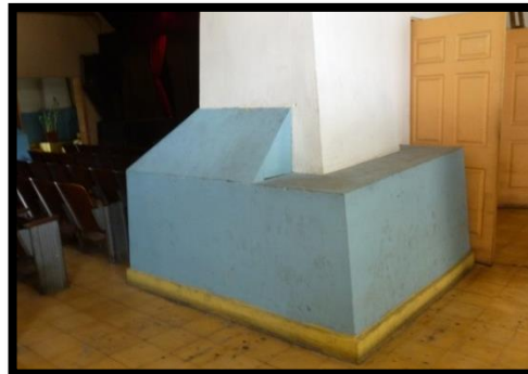
IMG.130 Vista de los elementos contrafuertes que sostienen las columnas
