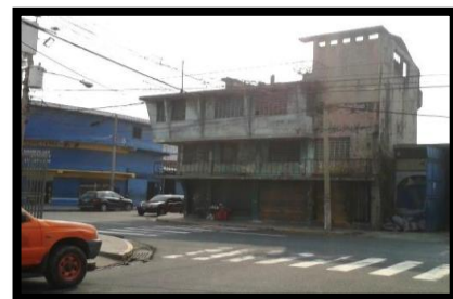
IMG.17 Edificaciones deterioradas en las cercanías del mercado San Miguelito
