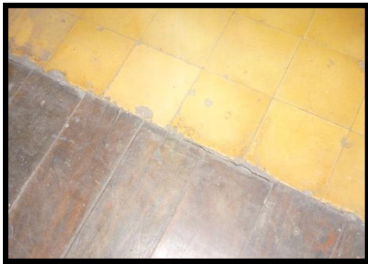
IMG.134 El Piso en el escenario es de duela de madera y de ladrillo de cemento pulido color amarillo en la sala del teatro.
