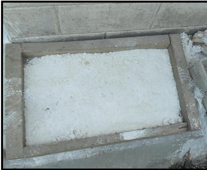
**Anexo 11. Pediluvio colocado en la puerta de la galera para evitar la entrada de contaminantes por medio del calzado.**
