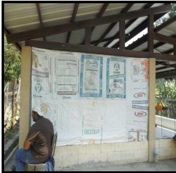
**Imagen 7. Colocación de cortinas rompe viento**
