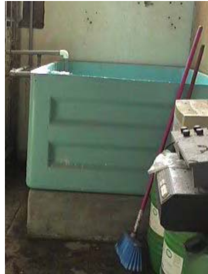
Fotografía 7. Tanque de almacenamiento.
