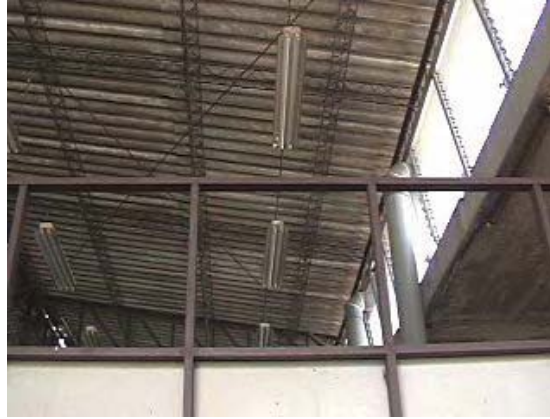
Fotografía 1. Pared e Iluminación del área del equipo de desmineralización.
