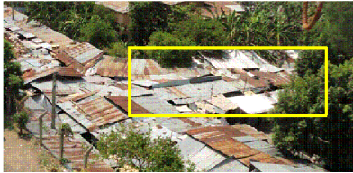
PERFIL ESTE Y OESTE (Antes de Reordenamiento, mayo 2013). 1
