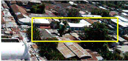
PERFIL ESTE Y OESTE (Antes de Reordenamiento, mayo 2013). 1
