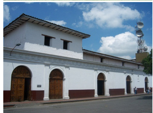
Imagen 109- Edificaciones coloniales sin aplicación del color.
