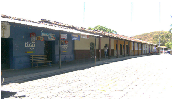
Imagen 61- Condición Actual del Portal Sur Fuente – Propia del investigador, agosto 2010
