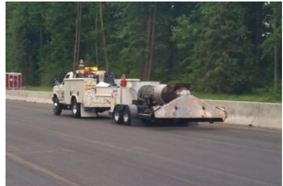
FIGURA N° 2.9 Secadora Jet utiliza Antes del Distribuidor riego de liga
