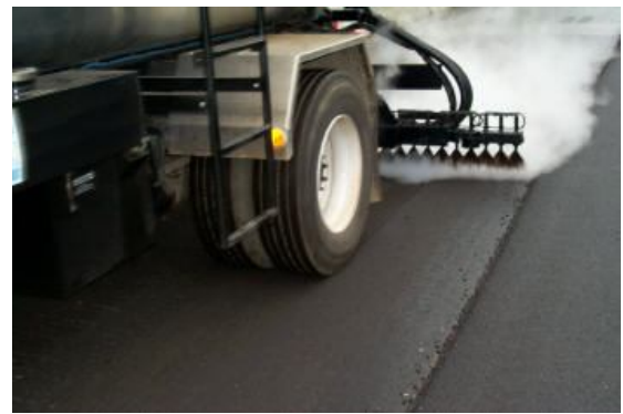
FIGURA N° 2.11 Aplicación del riego de liga Mostrando área de cobertura con Boquilla
