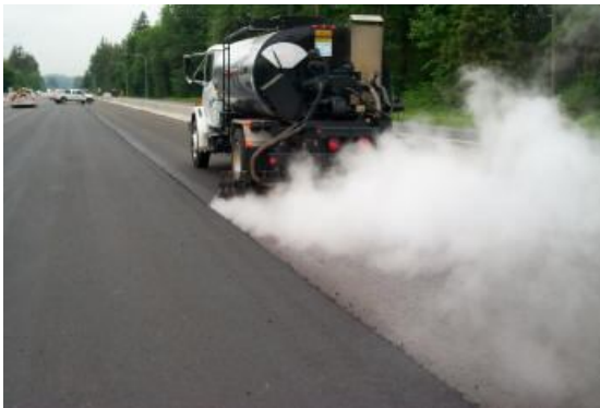
FIGURA N° 2.10 Aplicación del riego de liga
