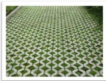
Ilustración 6: Muestra de adoquín ecológico.
