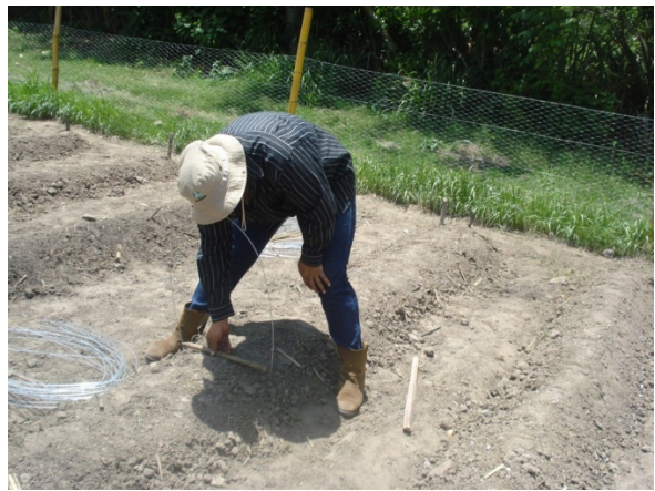
Figura A-14 Colocación de alambre para microtunnel
