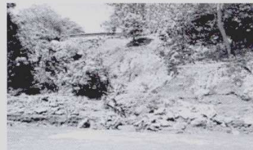
El río agudizó la cárcava en Joya de Cerén, por lo que urge un muro antes del próximo invierno.
