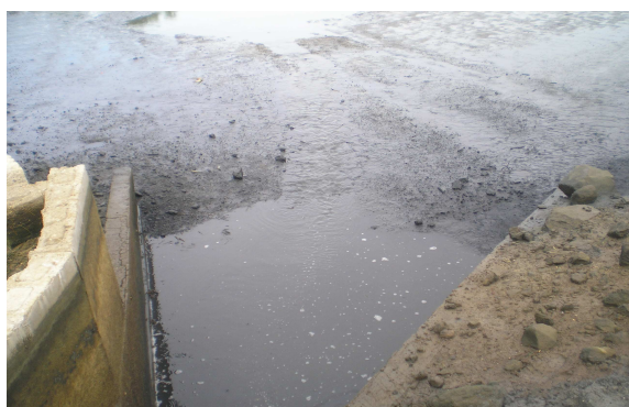
Figura 7. Drenado de estanque.
