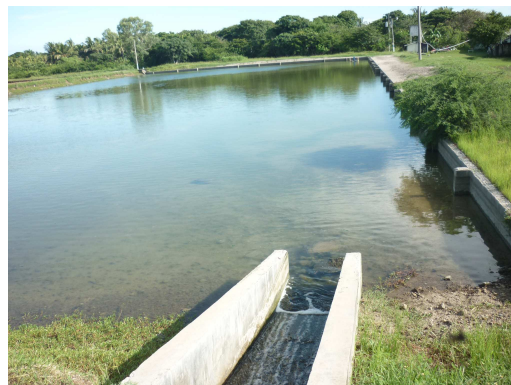
Figura 13. Llenado parcial de estanque.
