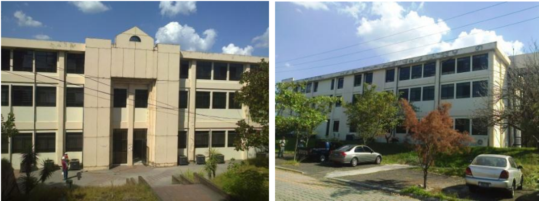
Figura 52: iluminación natural en el lado sur y norte del edificio.
