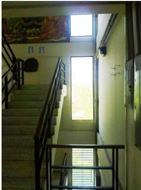
Figura 50: Ventanas del costado norte, deben permitir circulación del aire.
