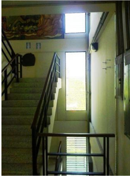
Figura 53: ventanas del costado norte, deben permitir circulación del aire.
