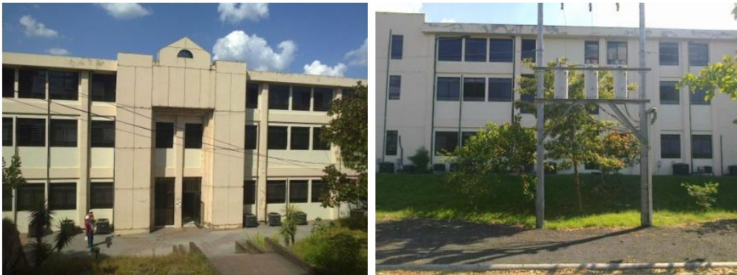
Figura 46: Aprovechar la ventilación natural abriendo la puerta principal.
