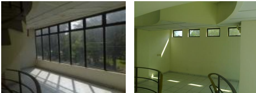
Figura 37: Ventanillas del costado poniente, deben permitir circulación del aire.
