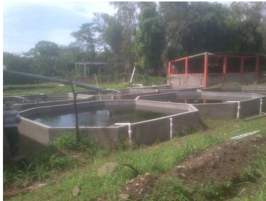
Figura A- 7. Pilas de cemento del Laboratorio A-2
