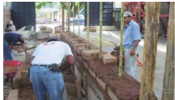
Fotografía F5.5c Colocación de las hiladas de adobe.
