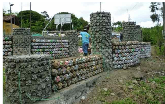
Fotografía F3.3e "Construcción de muros con eco ladrillo" Fotografía extraída del sitio web: http://www.ecotecnologia.com/porta/detalle_novedad.php?id=30
