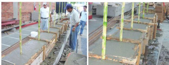
Fotografía F5.5b Muestra del acabado final de la superficie de la cimentación.
