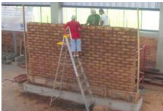
Fotografía F5.5e Pared reforzada.
