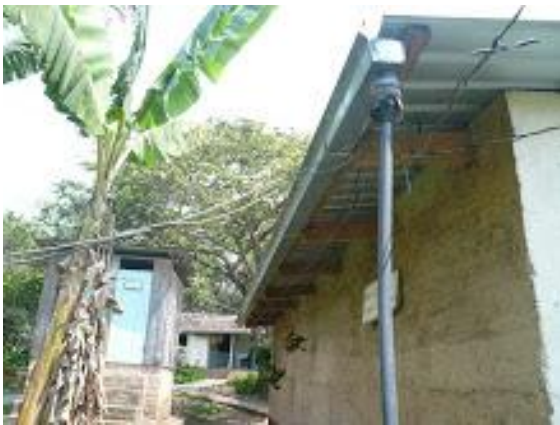
Fotografía F5.5h Canales de captación de aguas lluvias.
