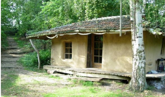
Fotografía F 3.4a Casa construida con adobe y paja sitio web: http://es.wikipedia.org
