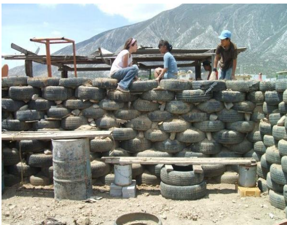
Fotografía F3.3c "Proceso de compactado de tierra en llantas" Fotografía extraída del sitio web: http://www.gonzo.com.mx/2011/11/cosas-hechas-con-llantas.html
