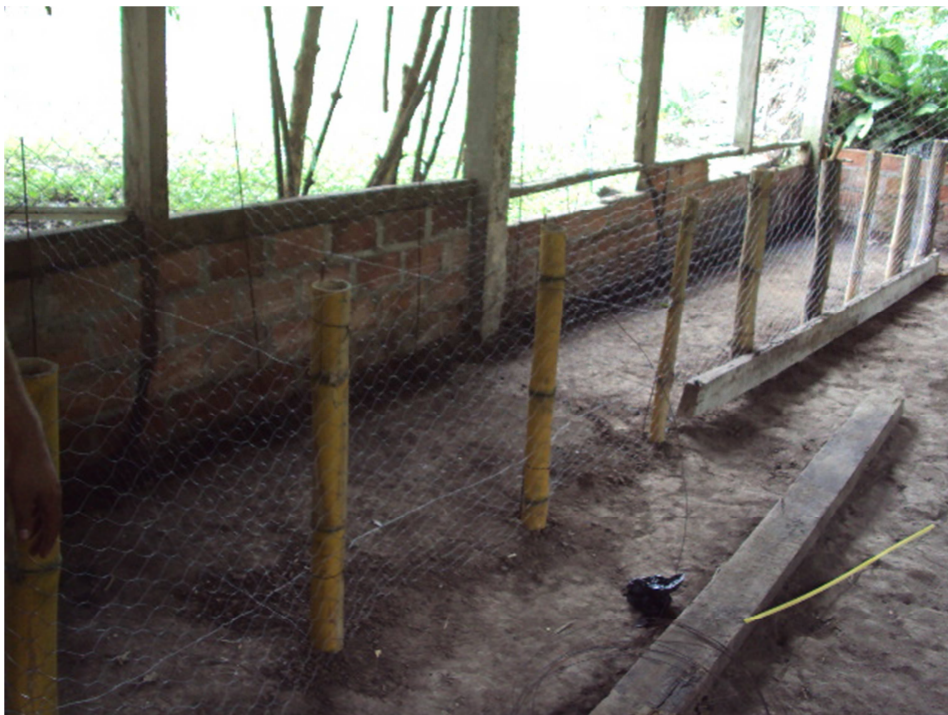
Figura A-8: Construcción de las divisiones para los tratamientos.
