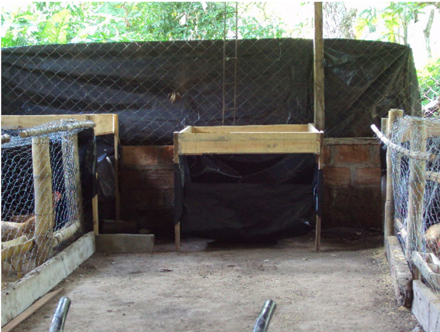
Figura A-11: Larvarios ya terminados y en funcionamiento.
