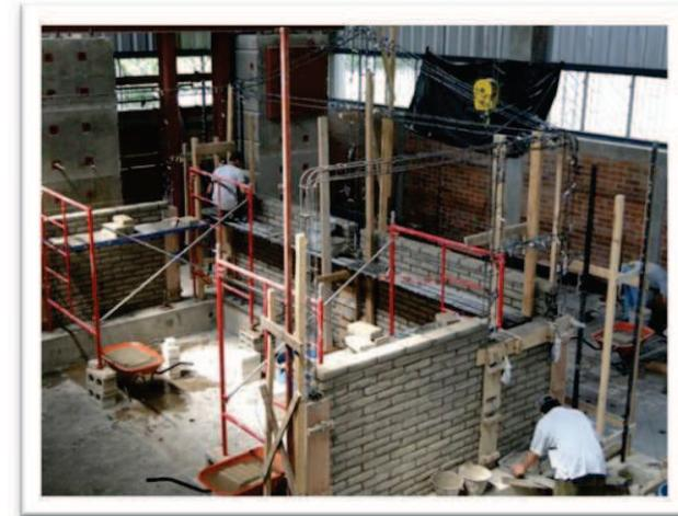
**FIGURA 22. Proceso constructivo de ladrillos de suelo cemento.**
