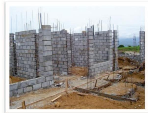
**FIGURA 23. Paredes de block de concreto con sistema mixto.**
