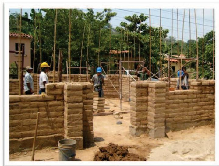
**FIGURA 21. Proceso constructivo de sistema de adobe sismo-resistente**
