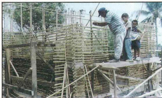
**FIGURA 19. Construcción de refuerzo del bahareque con vara de castilla.**
