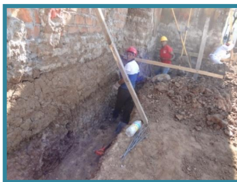
Fotografía N° 23 Obras de protección en las viviendas colindantes.
