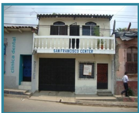
Fotografía N° 26 Vivienda de 2 niveles sobre la 5ª Av. Norte
