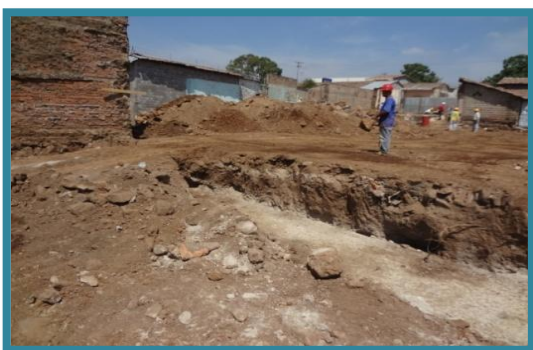
Fotografía N° 24 Ejecución de Obras Preliminares
