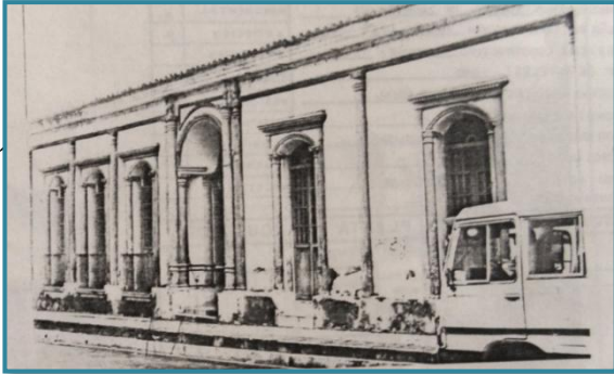
Fotografía N° 67. Dintel arco rebajado
