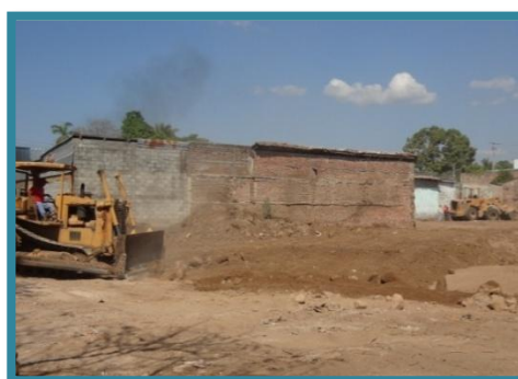
Fotografía N° 25 Obras de terracería
