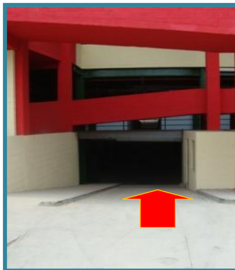
Fotografía N° 57 Acceso al Estacionamiento
