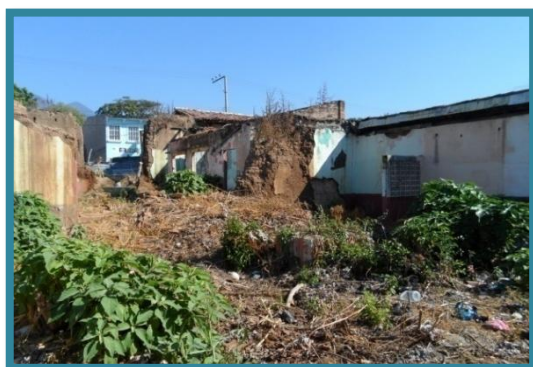
Fotografía N° 22 Condiciones físicas del terreno.
