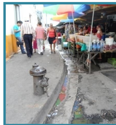
Fotografía N° 32 Hidrante ubicado sobre la 1ª Av. Norte y Pasaje Morazán.
