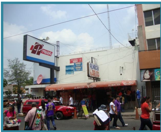
Fotografía N° 44 Los rótulos de los comercios que se ubican en el centro urbano generan una contaminación visual y obstruyen los detalles de algunas fachadas.
