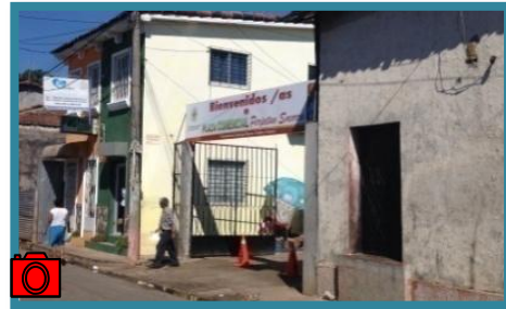
Fotografía N° 16 Acceso al terreno sobre la 6ª Calle Oriente
