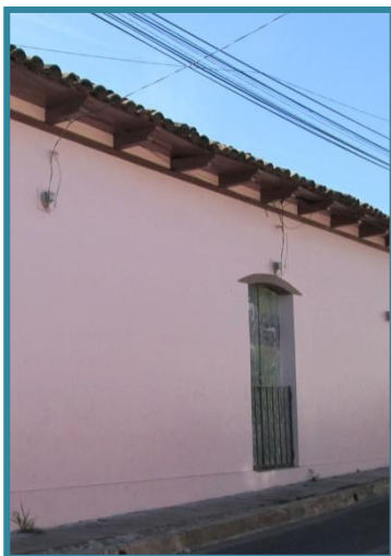
Fotografía N° 62. Alero de vivienda de Zacatecoluca.
