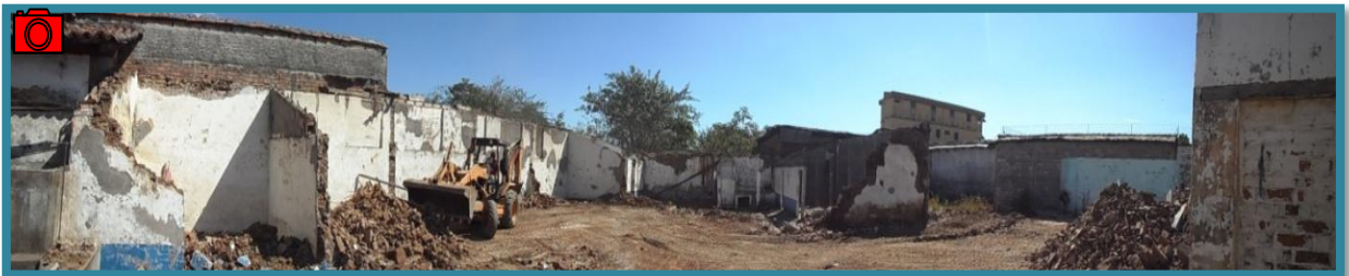
Fotografía N° 13 Vista Nor-Poniente del terreno
