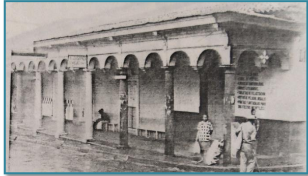
Fotografía N° 68. Casa de la Cultura, 2ª calle poniente.
