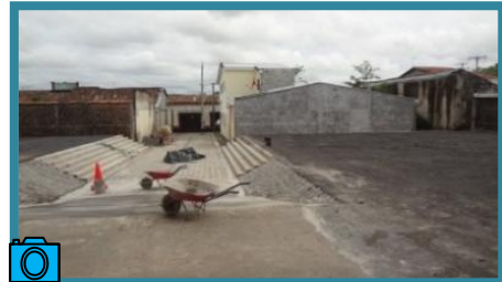
Fotografía N° 17 Vista interior sur del terreno
