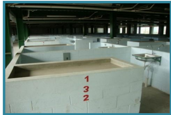
Fotografía N° 61. Ubicación de puestos en el segundo nivel
