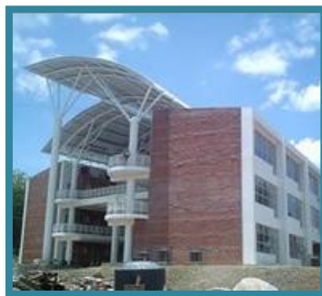
Fotografía N° 9 MEGATEC de Zacatecoluca
