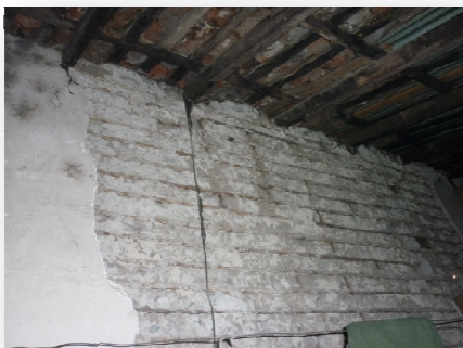
IMAGEN 22: PARED Y TECHO HAB-1 FUENTE: ELABORACIÓN PROPIA
