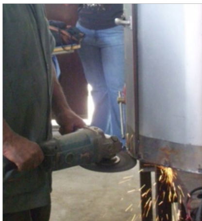
Pulido del refuerzo de la lamina de base
