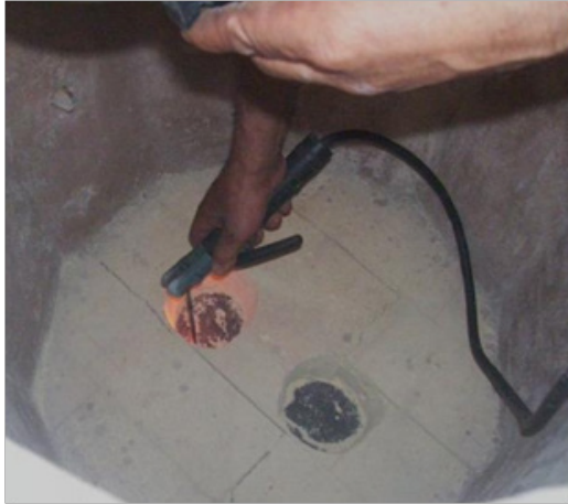
Momento en que se perfora la lamina
