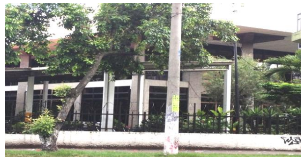
Foto 70. Columnas del Centro Judicial integrado de Nueva San Salvador.
