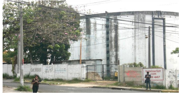
Foto 32. Mojón 3 Tanque de agua ANDA.
