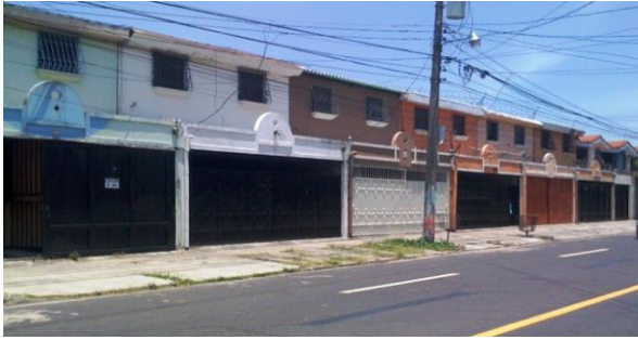
Foto 73. Tipo de vivienda de densidad media localizada en urbanización Jardines de Merliot.
