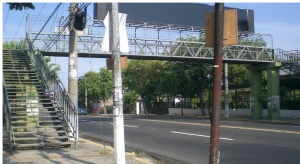
Foto 58. Pasarela ubicada al costado de Centro Judicial de Nueva San Salvador.
