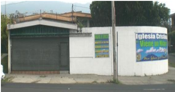
Foto 41. Rotulación Adherida o adosada a la pared en edificaciones Sobre Calle Chiltiupán.
