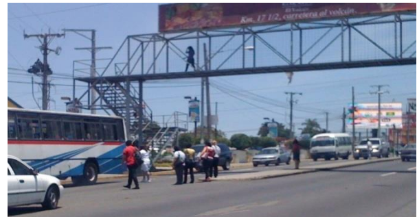
Foto 104. Peatones que no hacen uso de pasarela ubicada frente a Plaza Merliot.
