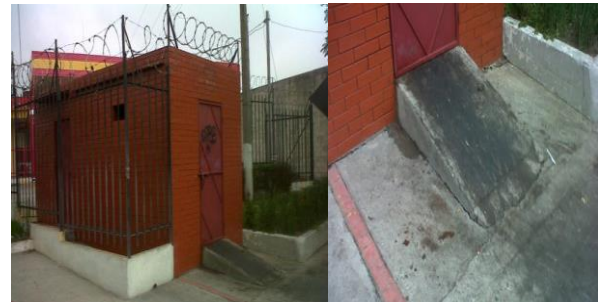
Foto 97. Depósito de basura restaurante Biggest ubicado entre Av. El Balsamar y Calle Chiltiupán.
