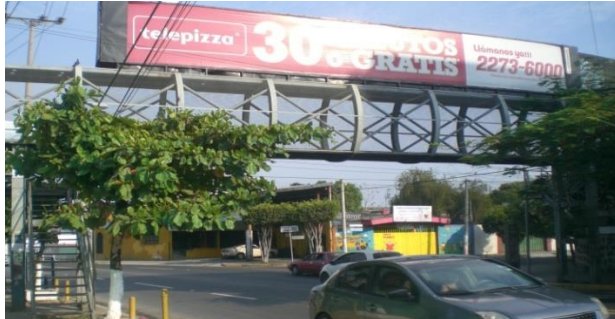
Foto 57. Pasarela ubicada a un costado del Colegio José Ingenieros.
