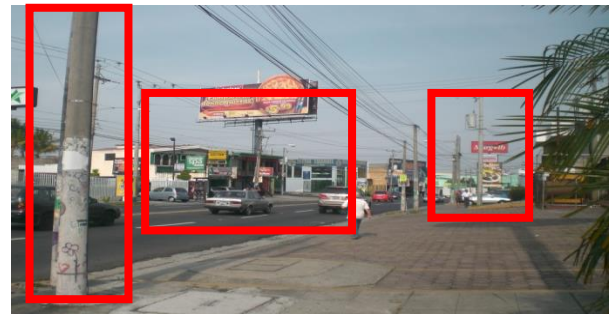
Foto 83. Saturación de postes de energía e iluminación. .
