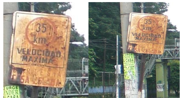
Foto 61. Señalización Vial en mal estado.
