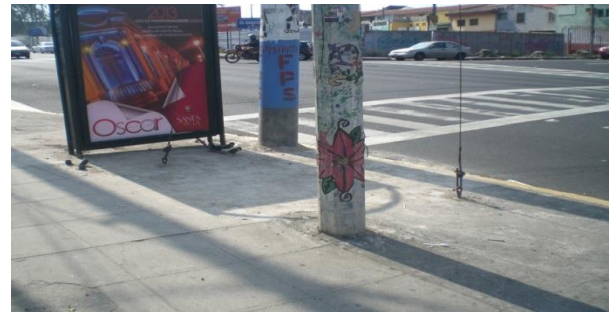
Foto 82. Ubicación de postes de manera desordenada que interfiere con el paso de peatones.
