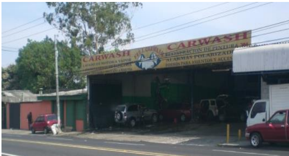
Foto 46. Rotulación sobre cubierta en edificaciones sobre Calle Chiltiupán.
