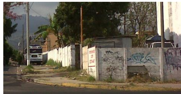
Foto 88. Muro perimetral Tanque ANDA, intersección calle Chiltiupán y 15a Av. Norte.
