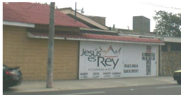
Foto 23. Iglesia Evangélica sobre Calle Chiltiupán.
