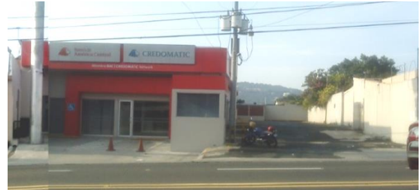
Foto 116. Estacionamiento de vehículos colectivo para un solo Comercio sobre Calle Chiltiupán.
