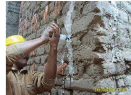
Imagen N° 2.10 Inyección de material para consolidación.
