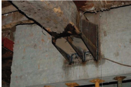
Imagen N° 2.11 Refuerzo Estructural en viga
