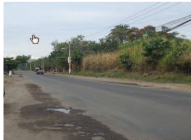
Imagen N°5.5. calle a Quezaltepeque
