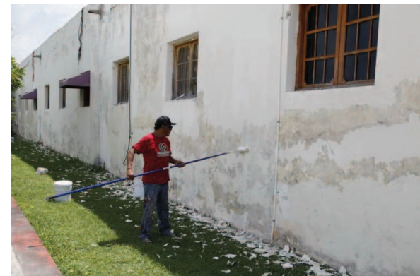
Imagen N° 9.7 Mantenimiento correctivo en pintura de paredes.
