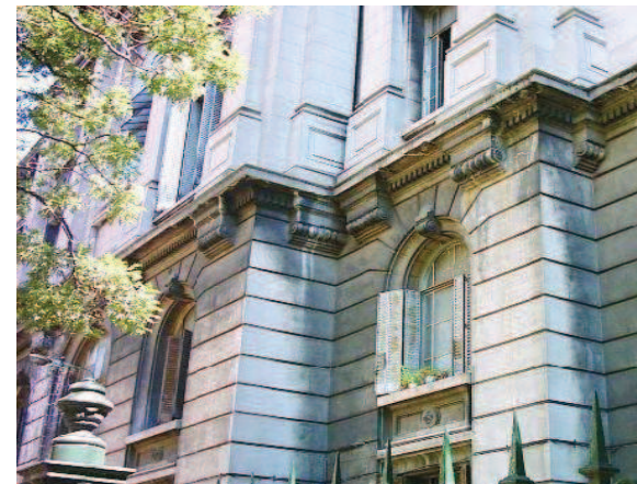
Imagen N° 7.4 Pátinas por lavado diferencial
