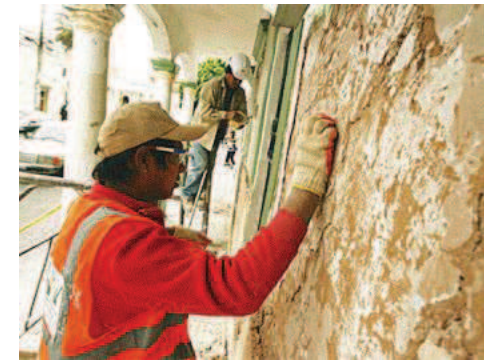
Imagen N°9.2 mantenimiento preventivo en paredes de adobe.
