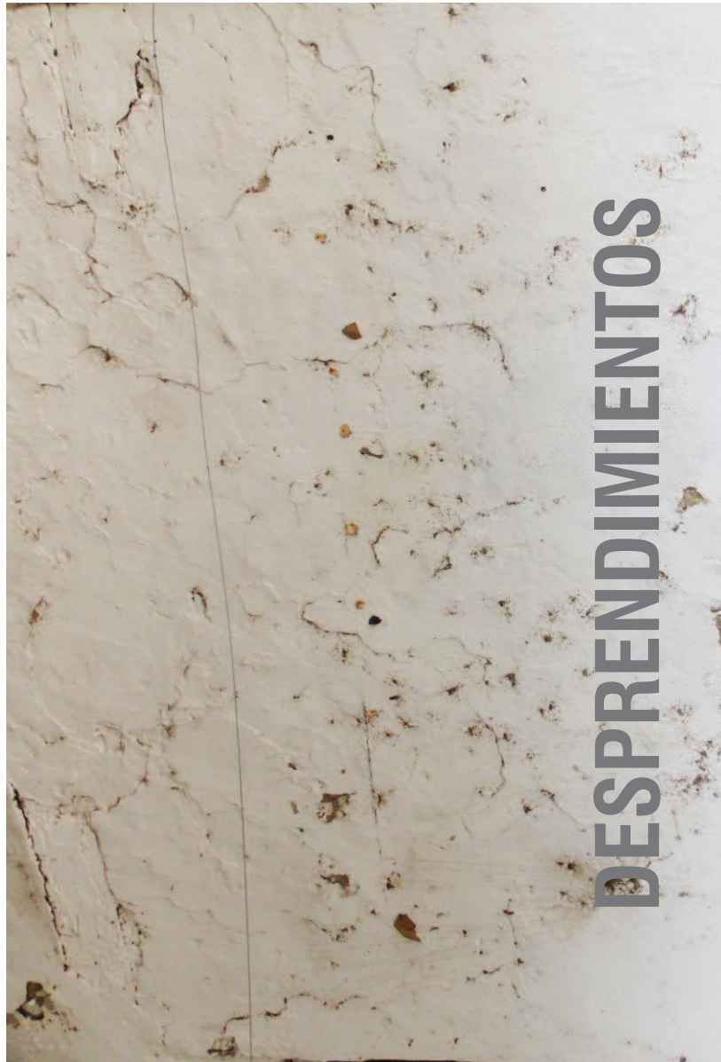
SOPLADURAS EN REPELLO DE PAREDES
