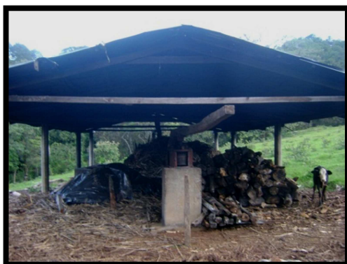
Molienda techada por completo
