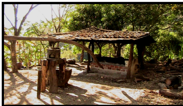
Molienda parcialmente techada.
