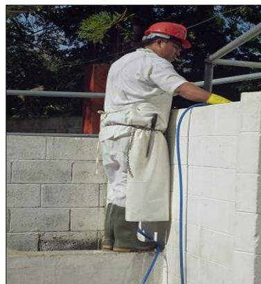
Fig. N° 58 Riesgo de caída a diferente nivel
