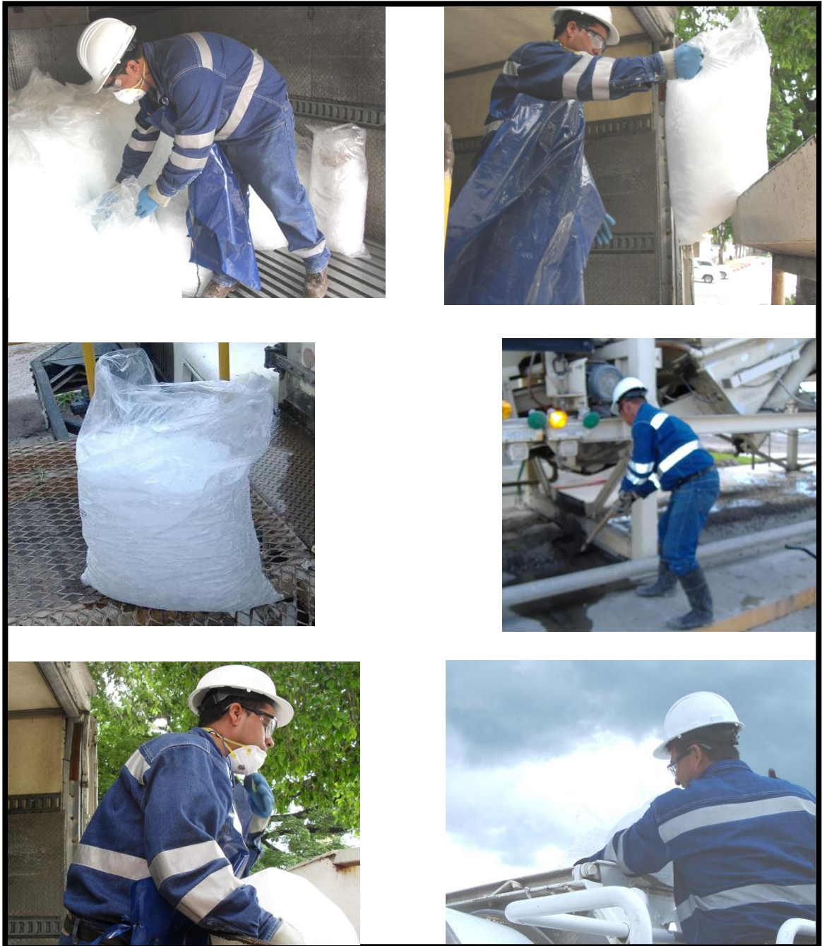
FIGURA Nº 67. Fotografías de los Auxiliares de proceso agregando bolsas de hielo a camión mezclador.
