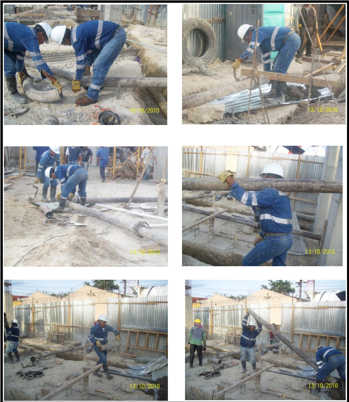
FIGURA Nº 62. Fotografías de los Ayudantes de bombeo cargando e instalando tubería.
