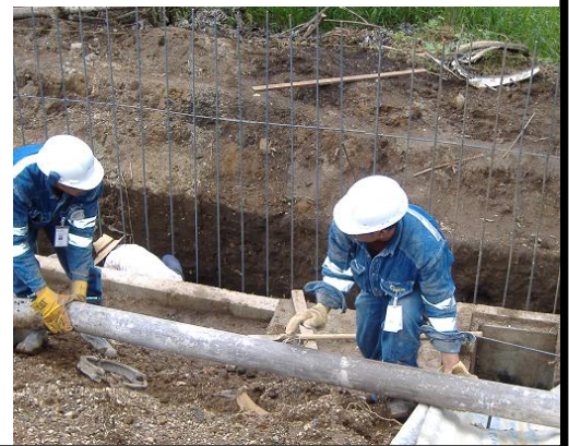
FIGURA Nº 64. Fotografías de los Ayudantes de bombeo instalando y realizando limpieza de tubería.
