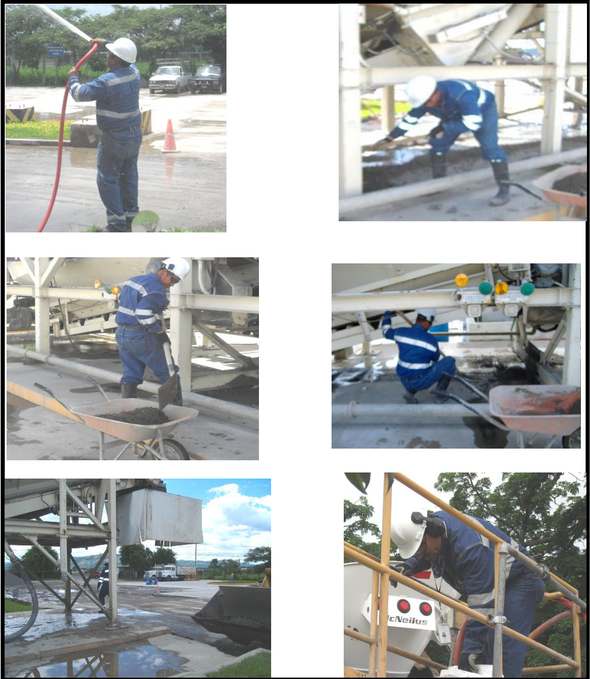
FIGURA Nº 68. Fotografías de los Auxiliares de proceso limpiando la zona de descargue y verificando consistencia de concreto.
