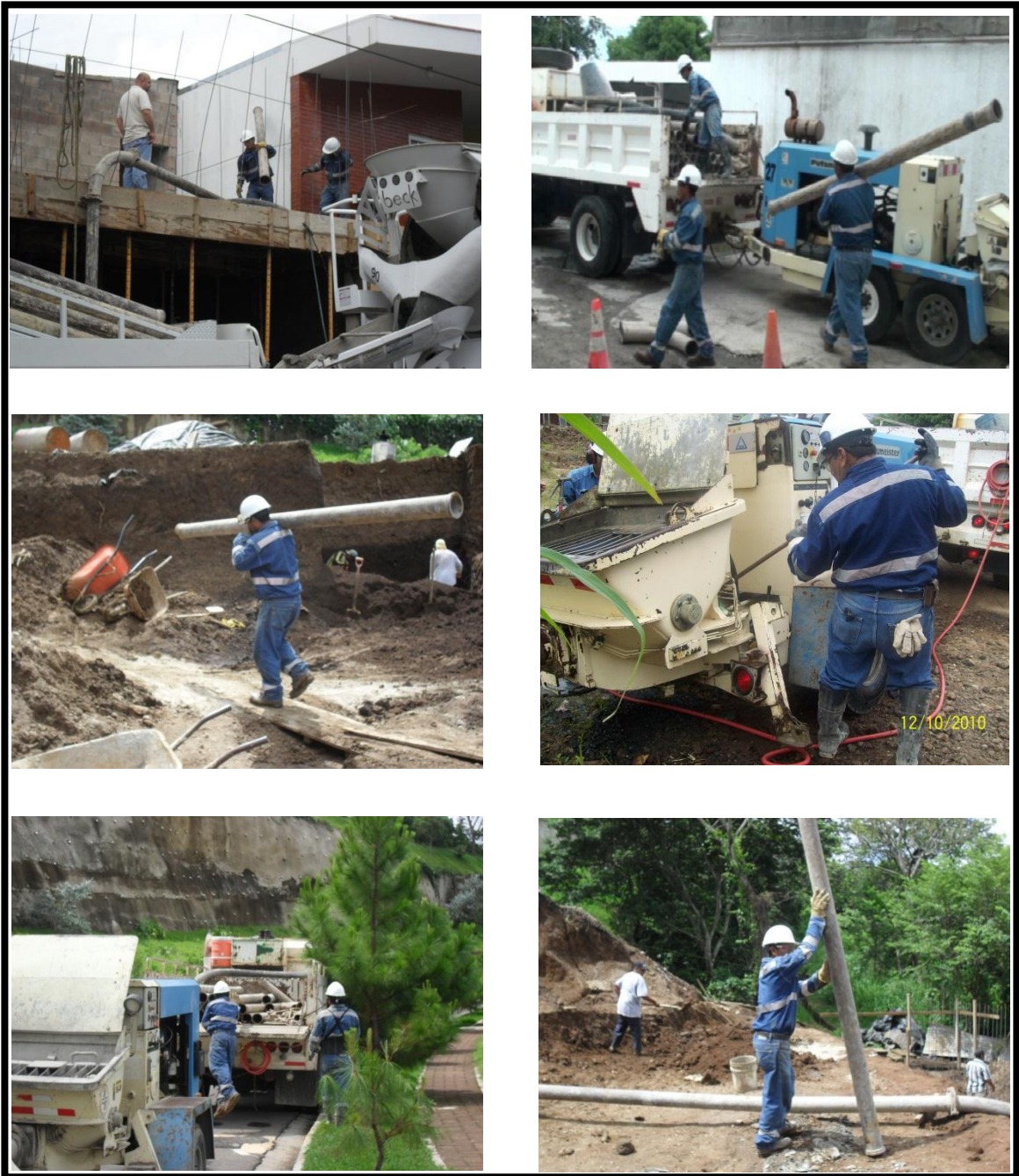
FIGURA Nº 63. Fotografías de los Ayudantes de bombeo cargando e instalando tubería.
