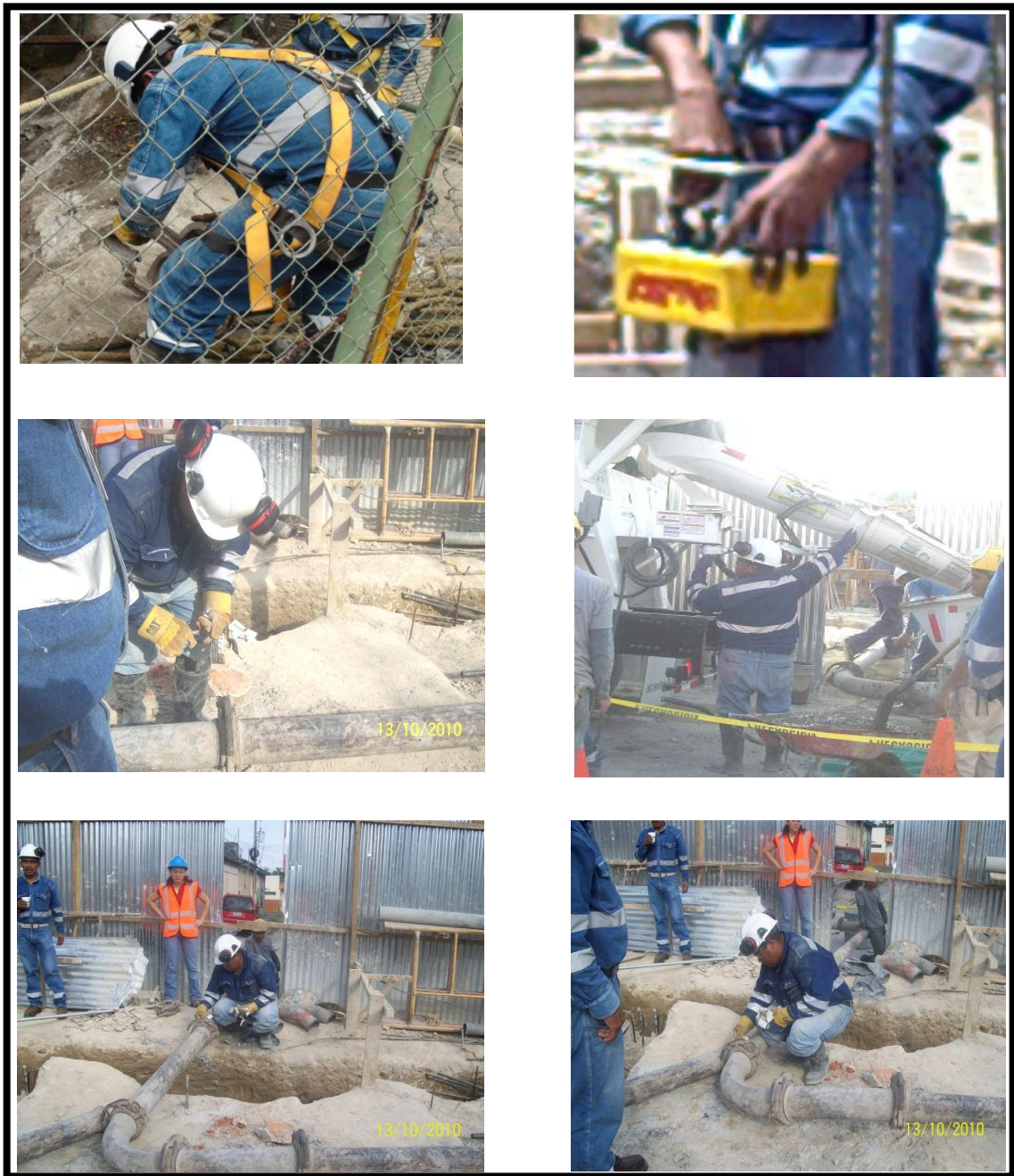
FIGURA Nº 61. Fotografías de los Operadores de bomba manejando los controles de la bomba e instalando tubería.
