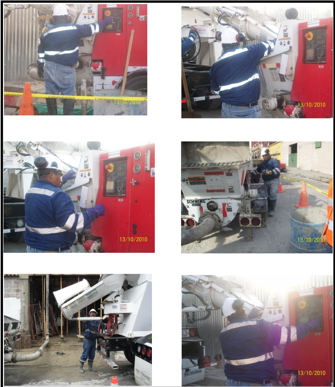
FIGURA Nº 60. Fotografías de los Operadores de bomba manejando los controles de la bomba.
