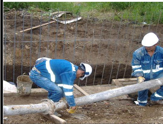
FIGURA Nº 64. Fotografías de los Ayudantes de bombeo instalando y realizando limpieza de tubería.
