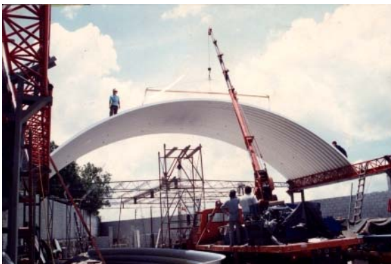
IMAGEN: 173 MONTAJE DE TECHO CURVO
