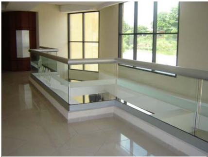
IMAGEN: 188 PASAMANOS DE ACERO INOXIDABLE CON PARAMENTO VIDRIADO
