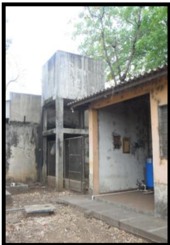
Tanque de concreto para suministro de agua.
