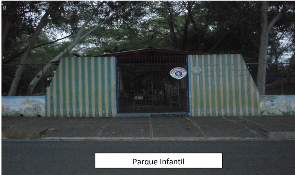
Fig. 2 Fachada del parque.
