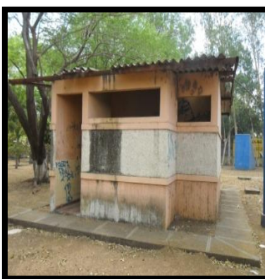
Infraestructura que sirvió para baños.
