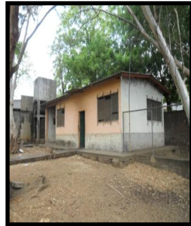
Administración y bodega.
