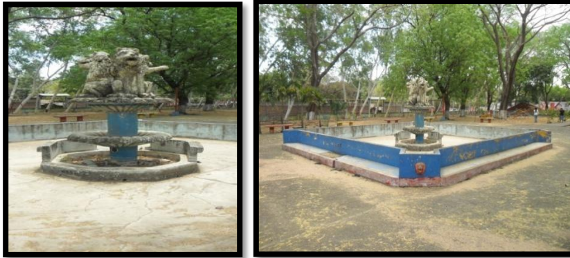
Una fuente de concreto en mal estado.
