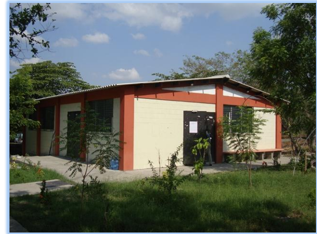
Imagen N° 31 Departamento de Ing. y Arq.
